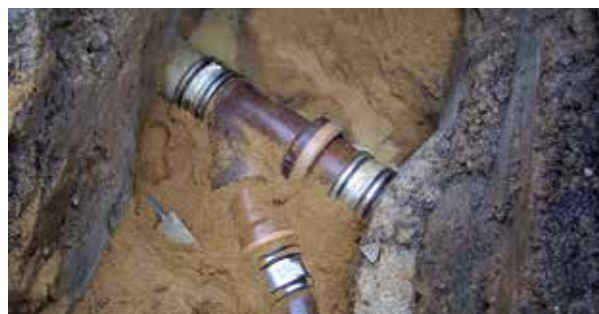
Reparatur einer Leitung in offener Baugrube
