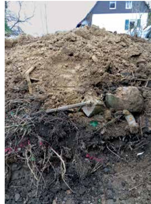
Ober- und Unterboden wurden durchmischt und mit Abfall durchsetzt
