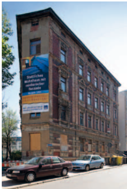
Gemeinsam sanierte Immobilie in Halle
