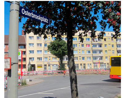
Den neuen Namen gibt es schon - bald ist die Umgestaltung des Stadtteilplatzes vor dem Elbschloss an der Bille in Hamburg abgeschlossen. (Foto: plan zwei)
