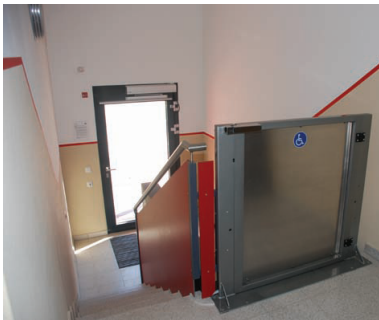
Die Schwellenfreiheit im Bestand wird in Arnstadt-Ost durch einen Treppenlift erreicht (Foto: empirica)
