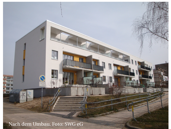
Vor dem Umbau. Foto: SWG eG
