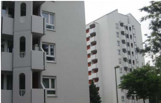
Die Punkthäuser nach erfolgter Sanierung.
