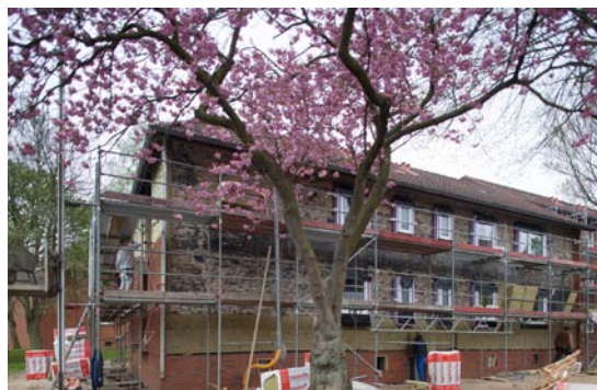
Die Sanierung schreitet in Fruerlung zügig voran.
