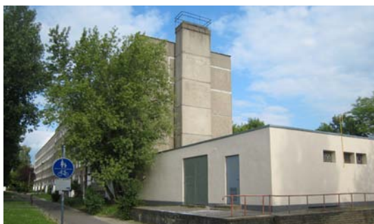
Das Gebiet wird über Nahwärmenetze mit einzelnen Heizzentralen versorgt.
