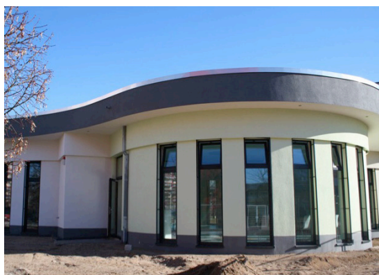
Der neu errichtete Nachbarschaftstreff „Schmetterlingshaus“
