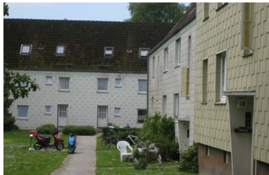
Die als „Flüchtlingsbauten“ in der Nachkriegszeit errichteten Gebäude werden weitgehend abgerissen.
