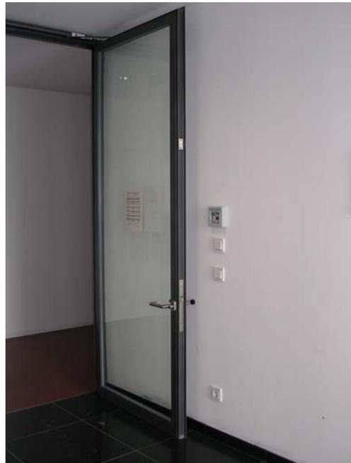
Tür im Erdgeschoss mit Türgriff auf 85cm. Deutlich zu sehen, dass die sonstigen Bedienelemente nicht in der Höhe angepasst wurden.
