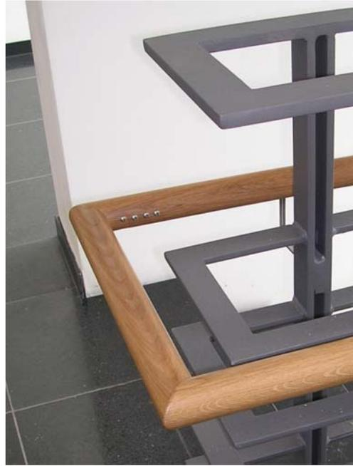
Taktile Erkennungszeichen mit Angaben zum Stockwerk helfen Blinden und Sehbehinderten bei der Orientierung im Gebäude, gut auch der runde Querschnitt des Haltegriffs und die Führung über das Treppende hinaus.
