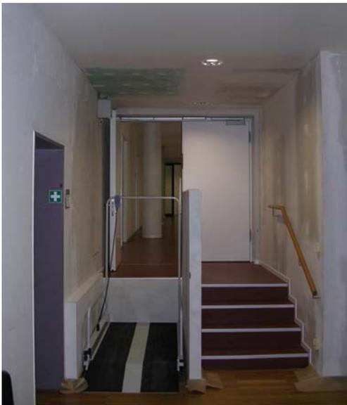
Da an einer Stelle der Höhengsprung zum Altbau zu groß war, musste eine Hubbühne eingebaut werden.
