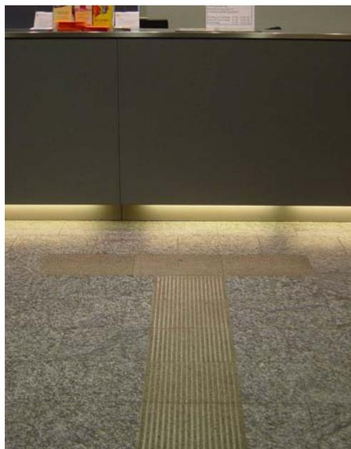
Die Leitlinie führt vom Außenbereich bis zum Informationstresen am Eingang; durch die strukturierte Oberfläche ist sie gut tastbar; der Kontrast zur Umgebung ist für Sehbehinderte allerdings zu gering, eine zusätzliche Einfassung etwa mit dunklem Material würde dies verbessern.
