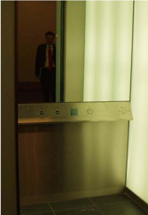
Außergewöhnlich gestalteter Aufzug im Altbau, der allen wesentlichen Anforderungen entspricht: Horizontale Bedieneleiste (Betätigung der Tasten wird durch leuchtende Umrandung deutlich angezeigt), Spiegel an der Stirnseite zur Orientierung bei Rückwärtsfahrten von Rollstuhlnutzern.
