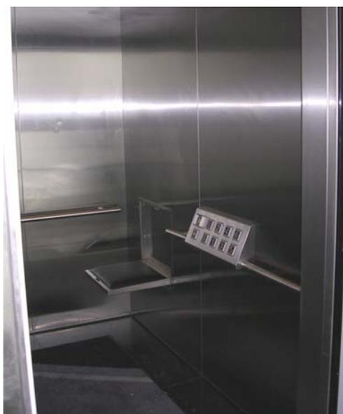
Der Fahrstuhl mit horizontalem Bedienfeld und Haltegriffen. Positiv auch der Klappsitz, schlecht hingegen, dass kein Spiegel an der Stirnseite für das Rückwärtsfahren von Rollstuhlnutzern existiert.
