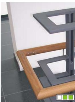
Handlauf mit gutem Querschnitt und Hinweisen zur Orientierung für Blinde, allerdings nur einseitig.
