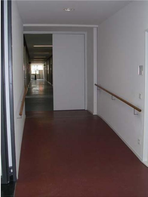
Als Rampe ausgebildeter Übergang zu einem der Altbauten, gut auch die Handläufe an beiden Seiten für leicht Gehbehinderte und die ausreichende Flurbreite.
