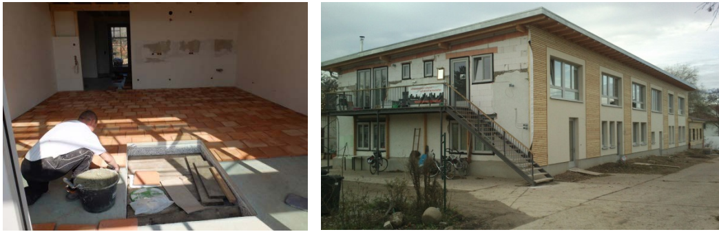
Abbildung 27: Bilder zum Baufortschritt
