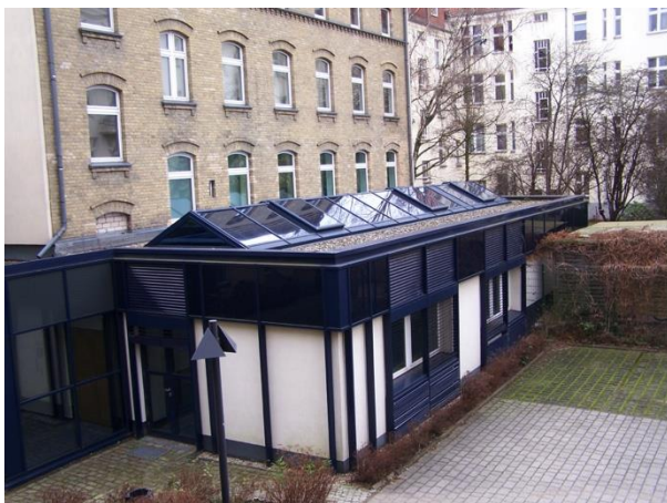
Abbildung 54: Hofgebäude Börnestraße 5A mit inzwischen abgerissenem Vorbau
