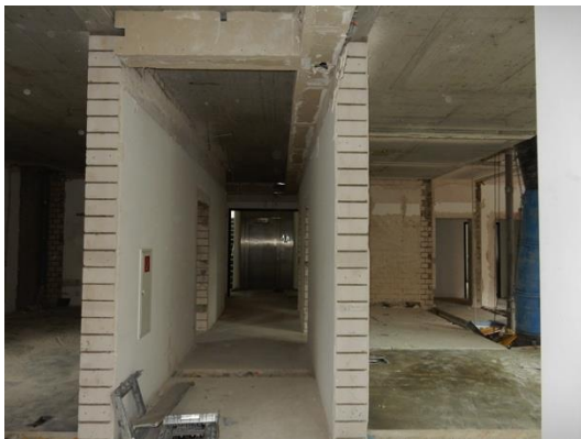
Abbildung 58: Entkernungsarbeiten in der Streustraße 117
