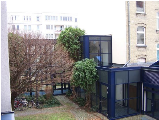
Abbildung 53: Hofgebäude Börnestraße 5A mit inzwischen abgerissenem Verbindungsanbau zum Vorderhaus Streustraße 118
