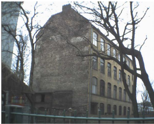
Abbildung 48: Altes Fabrikgebäude Charlottenburger Straße
