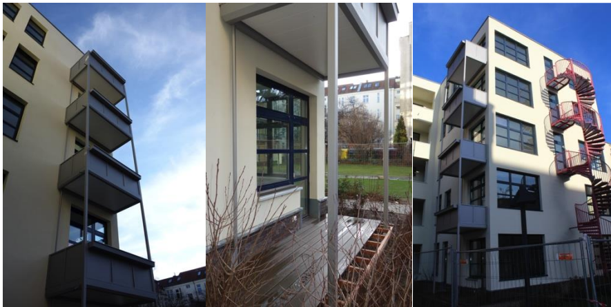
Abbildung 57: Hoffassade der Streustraße 117 mit vorgehängten Balkonen und Terrassen
