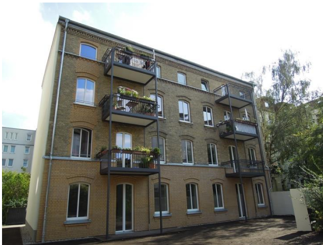
Abbildung 62: Klinkerfassade Hofgebäude Börnstraße 5A mit vorgestellten Balkonen
