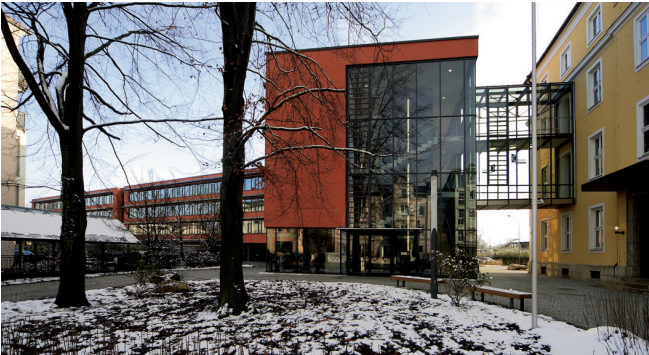
Hauptzollamt Rosenheim: Alt und Neu (Foto: Staatliches Bauamt Rosenheim, Peter Lion)
