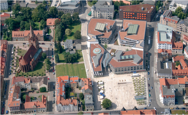
Paul-Wunderlich-Haus: Stadträumlicher Kontext (Foto: Landkreis Barnim)
