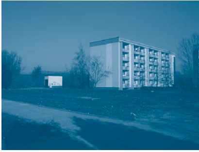
Rückbau 8-Geschosser in NDH-Ost
