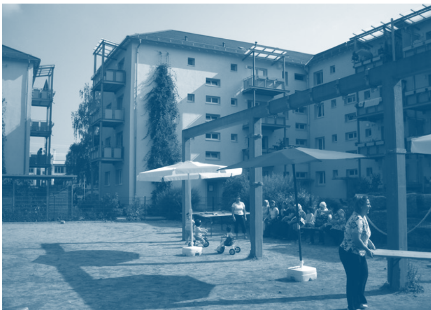
Modernisierte Wohnungen am BauHof (Foto: empirica)
