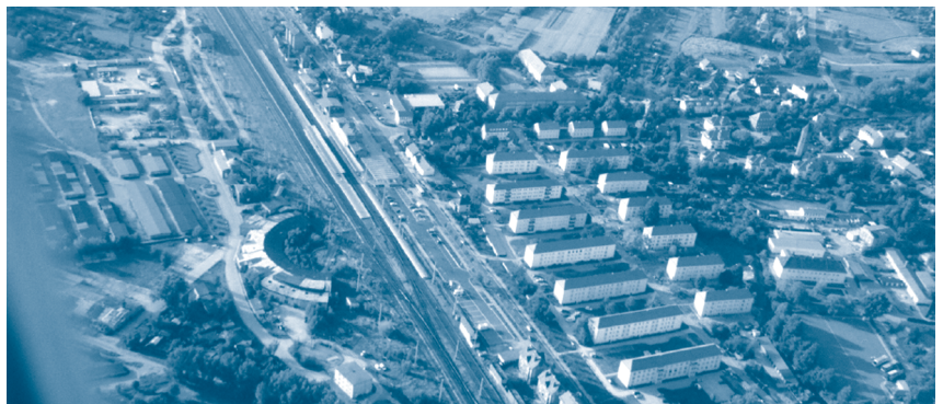
Abbildung 8: Blick auf den Teilraum Güterbahnhof (Foto: Jürgen Othmer)
