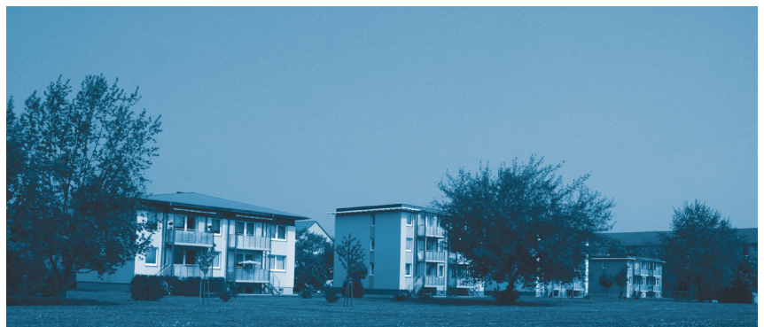
Abbildung 14: Niedrigenergiehäuser Albert Schweitzer Straße, Quelle: Stadt Tangerhütte
