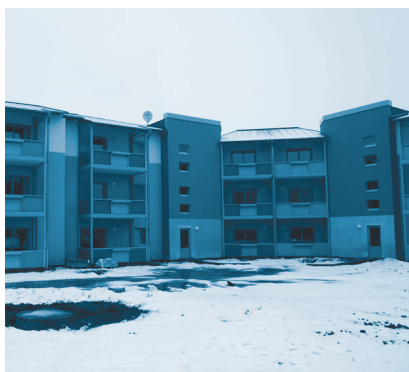
Abbildung 12: Neubau Gartenstraße Foto: Stadt Gräfenhainichen
