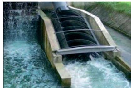
Der ehemalige Gewerbekanal mit Wasserschnecke zur Stromversorgung der Wärmepumpe
