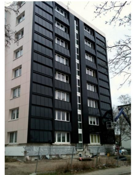
Fassade des Hochhauses vor dem Umbau (links) und nach dem Umbau mit Photovoltaik-Paneelen (rechts), Fotos: Genossenschaft 1892
