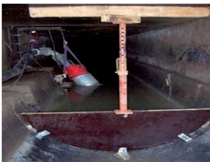
Erfolgreicher Einbau des Wärmetauschers in den Hauptsammler,
