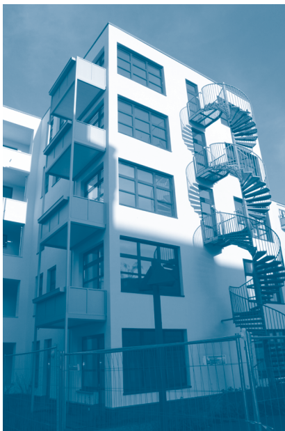
Hofseitige Außenansicht der Streustraße 117 mit saniertem Fassade und vorgeständerten Balkonen im Januar 2016 (Foto: RegioKontext)
