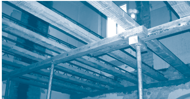
Einzug neuer Decken in der Streustraße in Berlin (Foto: GESOBAU)
