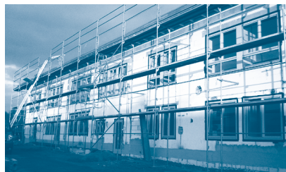
Baufortschritt außen (Foto: empirica)
