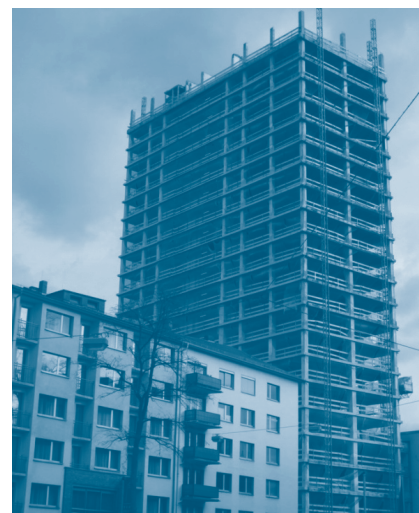
Rückbau eines Bürogebäudes bis auf den Stahlbetonskelettbau (Foto: Stadt Frankfurt)
