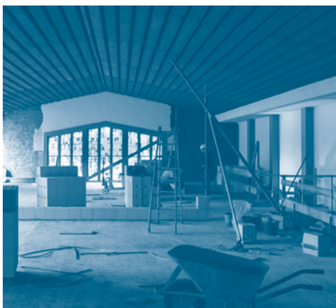
Umbau der Markuskirche in Gelsenkirchen Buer (Foto: RegioKontext)
