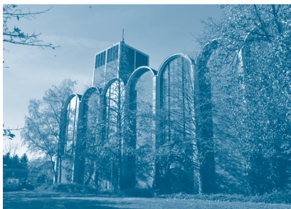
Buntverglasungen an der Nord- und Südfassade
