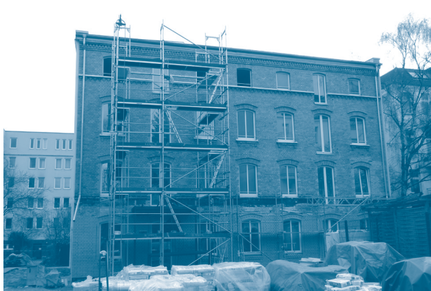
Hofgebäude in der Börnestraße 5 nach Abbruch des Verbindungsbaus
