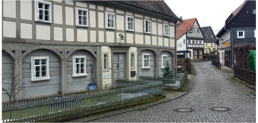
Ungefähr 660 Umgebinderhäuser prägen das Bild von Großschönau Foto: Hochschule Neubrandenburg
