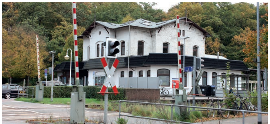
Das Bahnhofsareal soll mit multifunktionaler Nutzung zum attraktiven Tor in die Stadt werden
