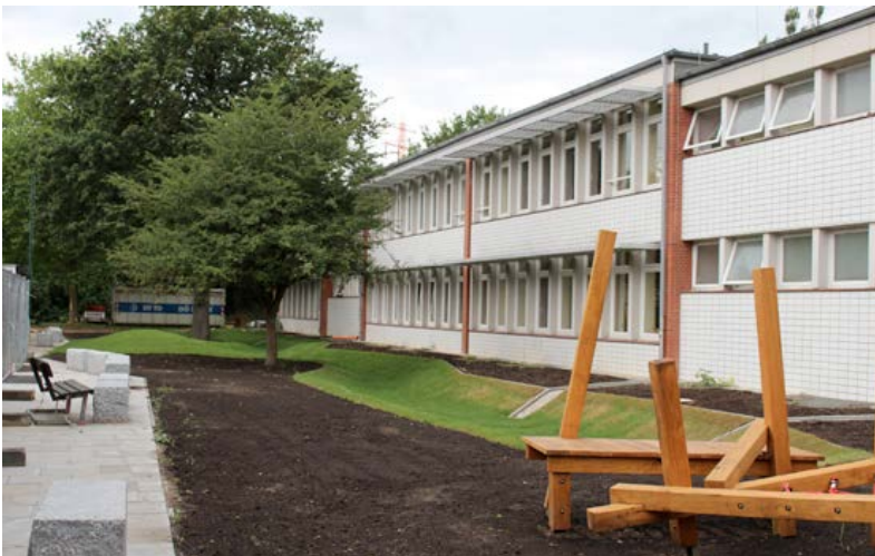
Der Schulhof in der Umgestaltung. Im Hintergrund ist eine Regenwassermulde mit den offenen Zuläufen zu erkennen; im Vordergrund ein Balancierparcours und links am Rand Sitzsteine (Foto: BSU)
