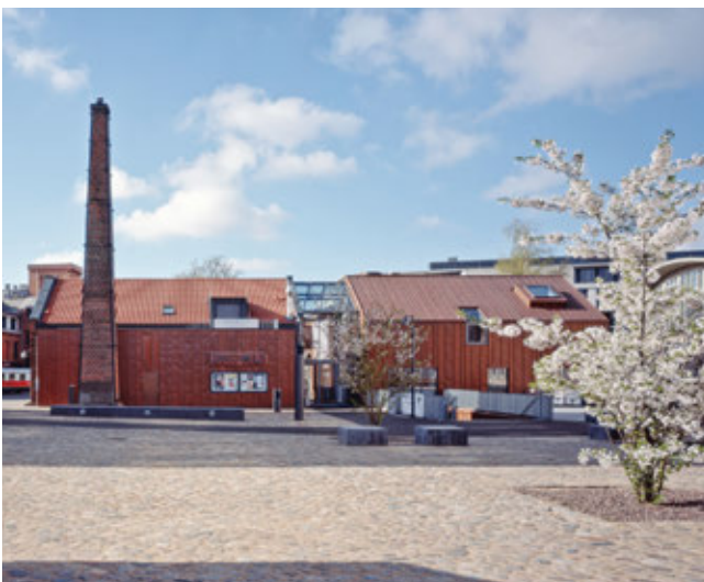
Zinnschmelze Hamburg-Barmbek nach Umbau und Erweiterung
