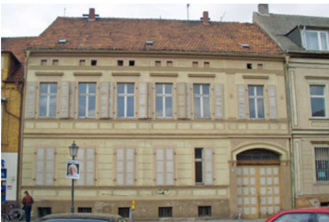
Stadtbildprägendes Gebäude in Luckenwalde vor der Sanierung
