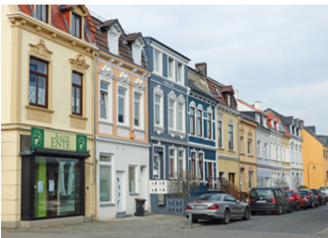
„Bremer Häuser“ in der Grenzstraße in Bremen-Walle
