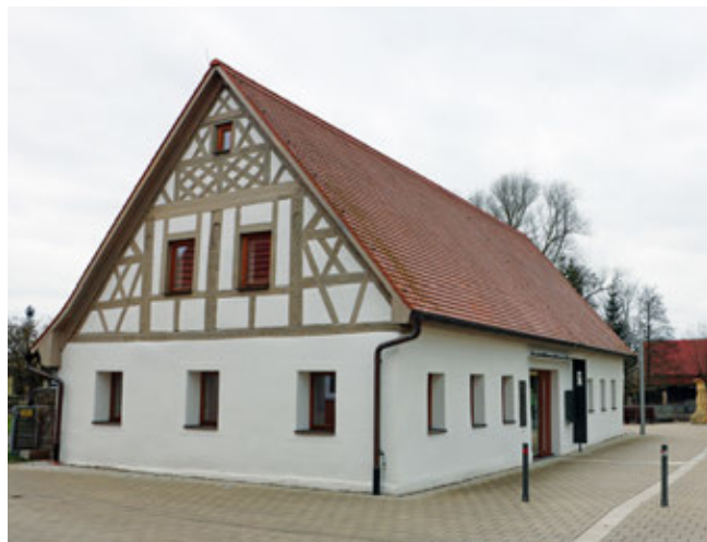
Bürgerhaus Litzendorf nach der Sanierung
