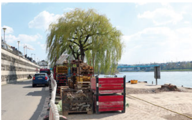
Schutz vor Rheinhochwasser: Umgestaltung Deichvorgelände Neuwied
