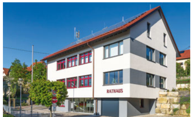
Energetisch saniertes Rathaus in Burgstetten
