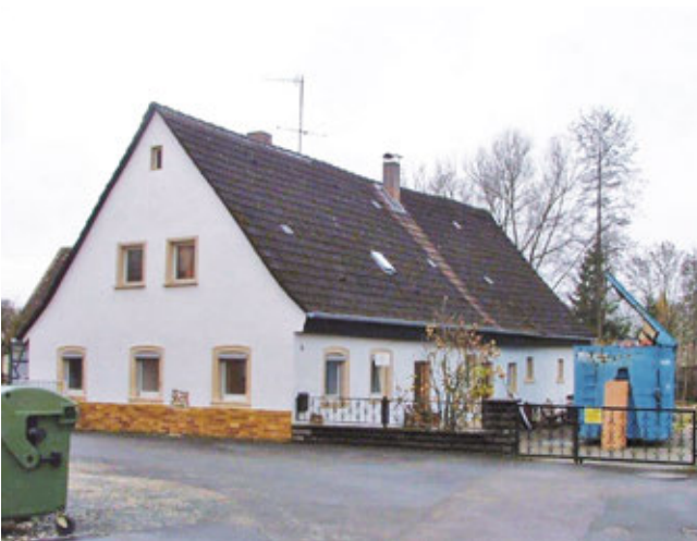
Bürgerhaus Litzendorf vor der Sanierung
