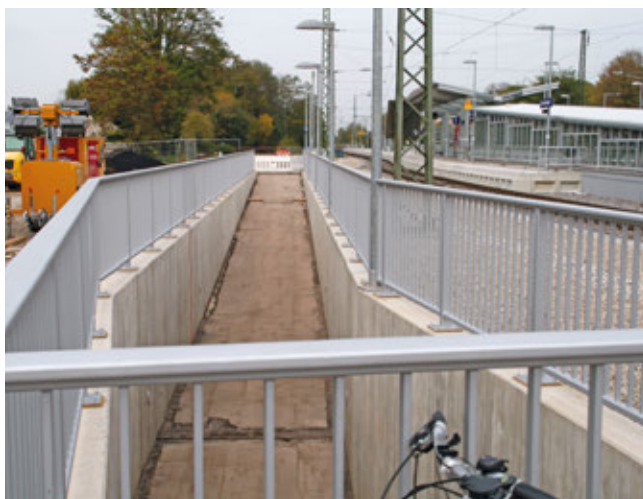
Barrierefreier Zugang Bahnhof Emmendingen
