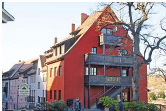
Energetisch saniertes Gebäude in Nürnberg
