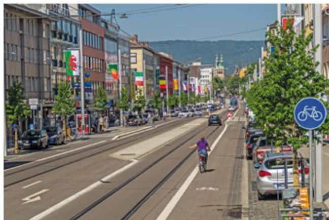
Friedrich-Ebert-Straße in Kassel nach dem Umbau
