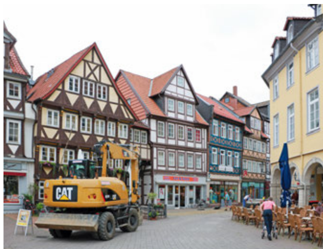
Umbau Fußgängerzone Wolfenbüttel
