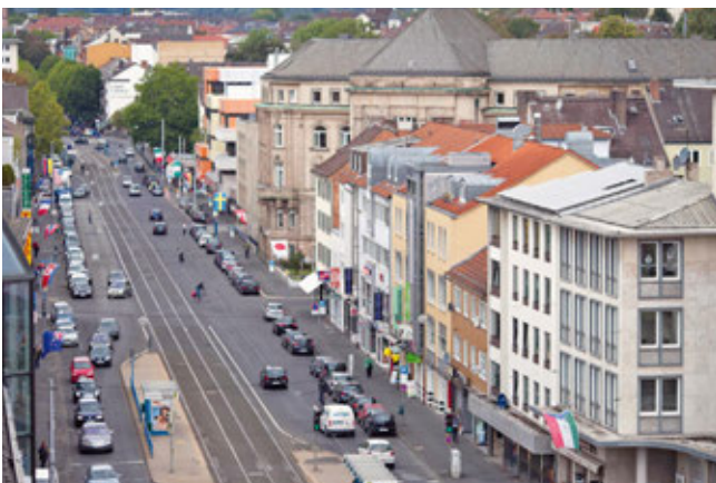
Friedrich-Ebert-Straße in Kassel vor dem Umbau
