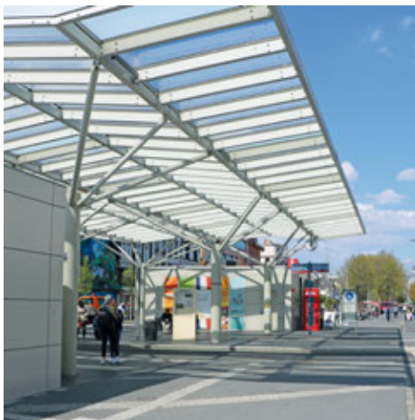
Neue zentrale Busstation in Neuwied
