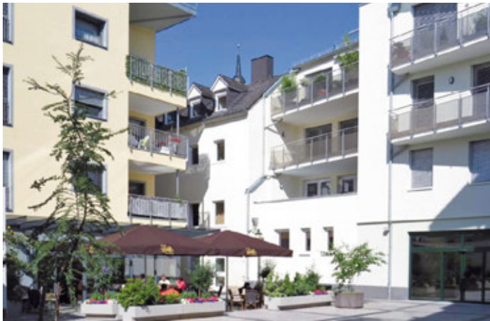
Wittlich: „Altstadt, die Neue“ mit Stadtplatz in Wittlich
