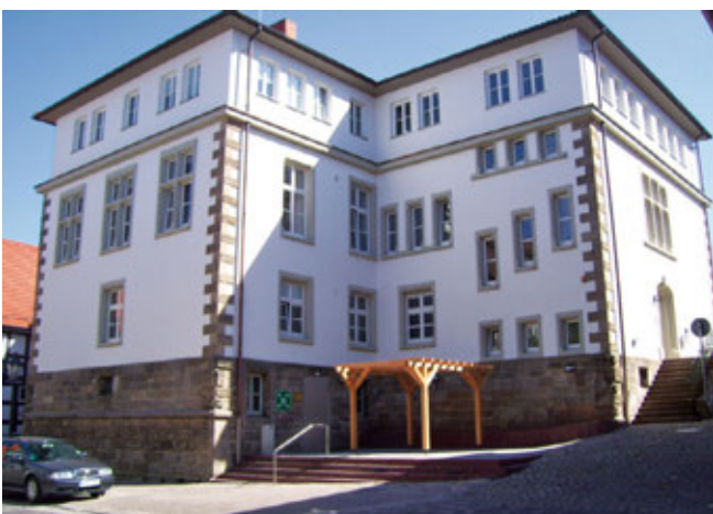
Ehemaliges Amtsgericht Wolffhagen nach der Sanierung
