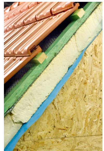
Bauteile wie Dächer, Aussenwände oder Zwischendecken müssen in der Regel F90 sein. Sie bestehen aus mehreren Schichten und Materialien mit unterschiedlicher Brennbarkeit. Quelle: Alterfalter/ Fotolia
