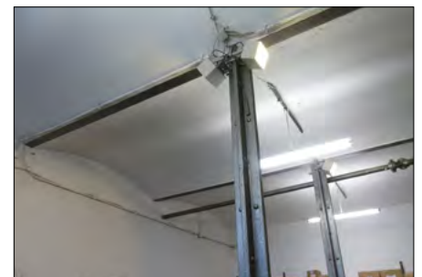
Verputzte Kappendecke mit Stahlträgern und -stützen – Westwerk Leipzig
