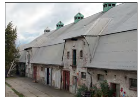
Blechdachdeckung im Alten Schlachthof OSTRALE Dresden
