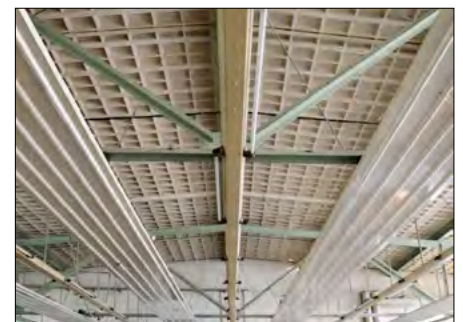
Sonderkonstruktion aus Spannbetonplatten auf Stahlfachwerkträgern – Oranienwerk Oranienburg
