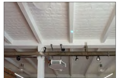
Gestrichene Stahlsteindecke – Baumwollspinnerei Leipzig
