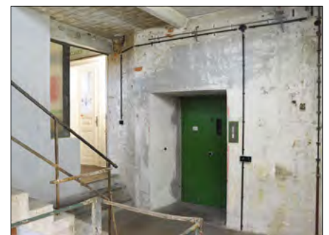
Teilweise verputzte Wand aus Ziegelmauerwerk – Tapetenwerk Leipzig
