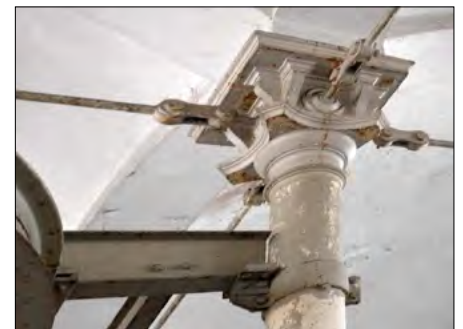
Aufwendig gestaltetes Kapitell einer gründerzeitlichen gusseisernen Stütze – Alter Schlachthof Karlsruhe
