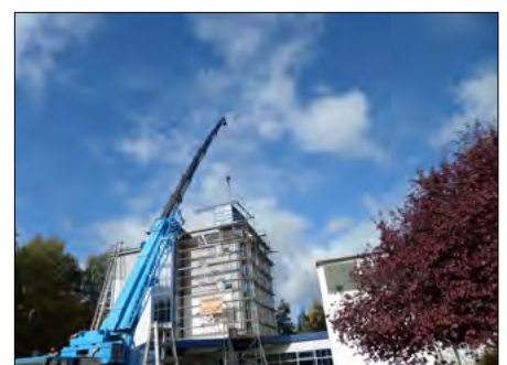
Einhub des Moduls in Freiberg, Fotos © C + P
