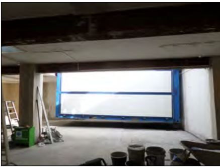
Stahlträger zum Abhängen und abgehängtes Modul, Fotos © C + P
