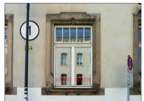
Kastenfenster in Verwaltungsgebäude mit Jugendstilfassade – Baumwollspinnerei Leipzig
