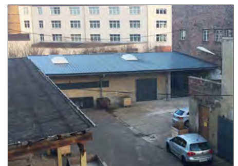
Trapezblechdach – Tapetenwerk Leipzig
