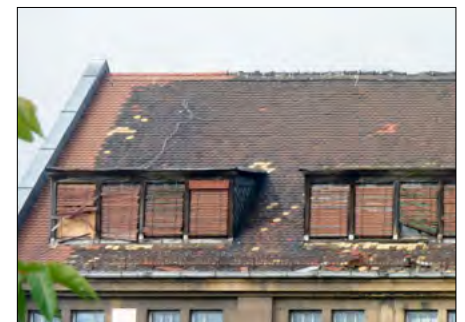
Zur Substanzsicherung giebelseitig verbesserte Biberschwanzdeckung
