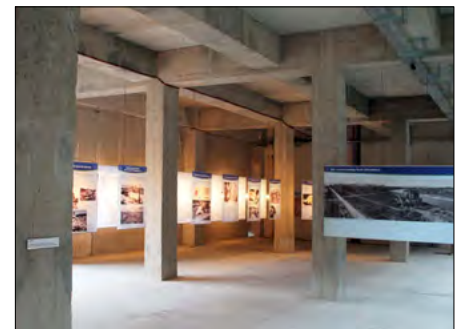
Gesandstrahlte Betonoberfläche – Kraftwerk Mitte Dresden
