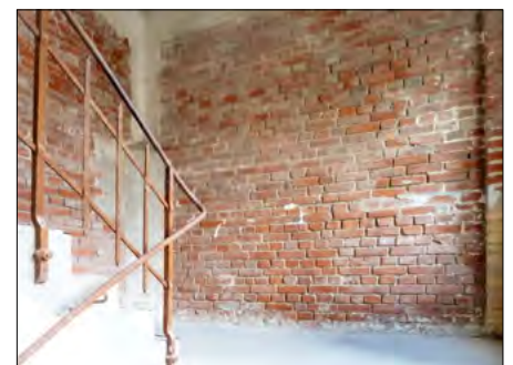
Nach Entfernen des Wandputzes unbehandelt belassene Ziegeloberfläche – Dietzoldwerke Leipzig
