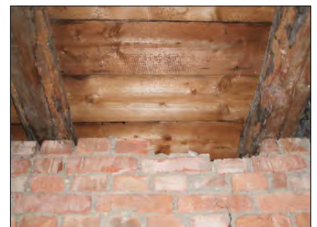
Holzbalkendecke ohne Füllung und Schalung
