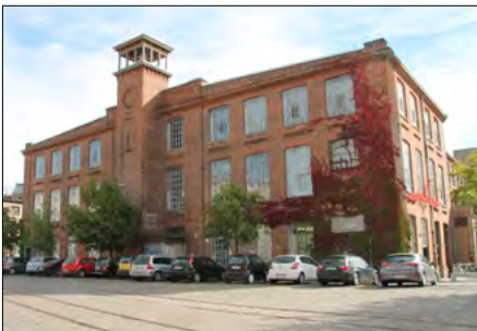
Klinkerbau auf dem Gelände der Baumwollspinnerei Leipzig
