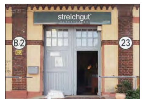
Zweiflügeliges einfaches Holztür mit Oberlichtverglasung aus der Gründerzeit – Baumwollspinnerei Leipzig
