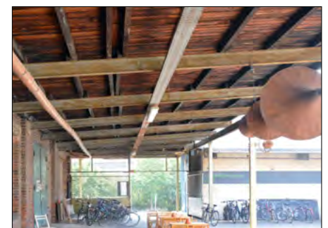
Stahlträgerkonstruktion eines Vordachs im Tapetenwerk Leipzig
