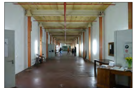
Flachdecke mit Stahlträgern in der Baumwollspinnerei Leipzig
