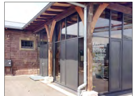
Reparierte historische Holzkonstruktion mit eingestelltem modernen Pavillon – Alter Schlachthof Karlsruhe
