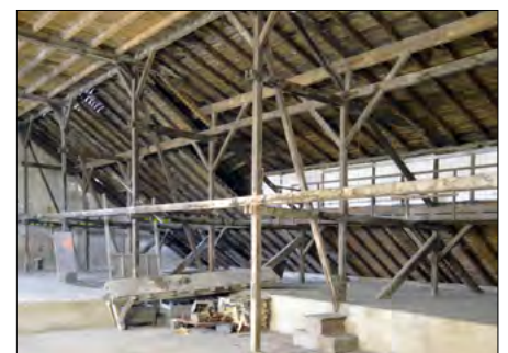
Imposante Holzdachkonstruktion in noch ungenutztem Dachraum – Erzwäsche Freiberg
