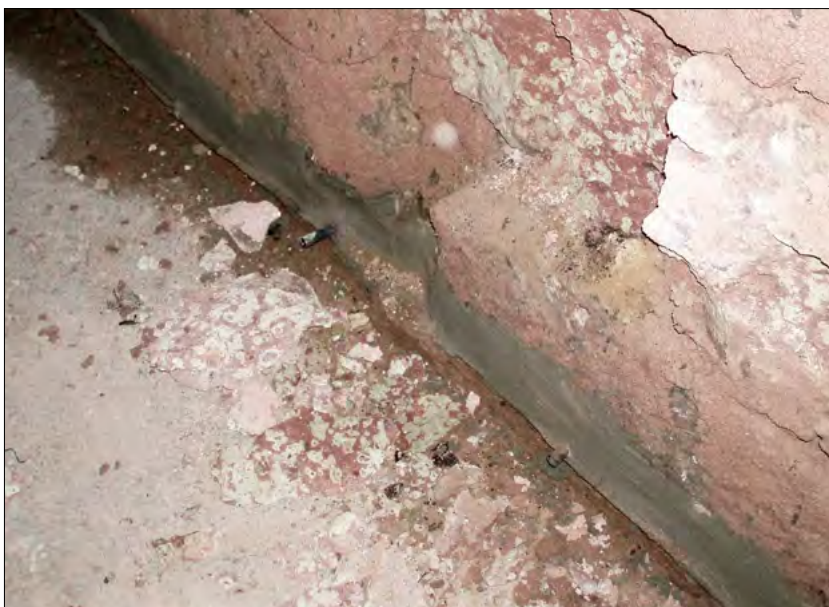
Nachträgliche Horizontalabdichtung im Sägeverfahren mittels Kunststoffplatten
