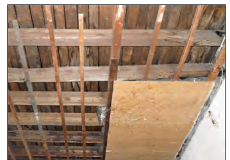
Rest einer alten Deckenverkleidung mit sichtbarer Unterkonstruktion
