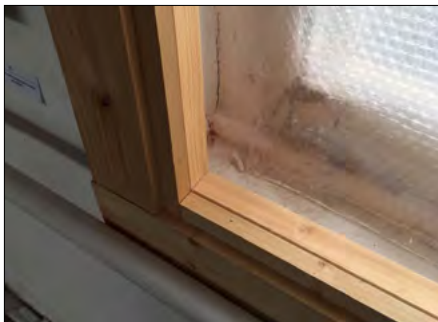
Luftpolsterfolie als Isolierung Kulturfabrik Apolda
