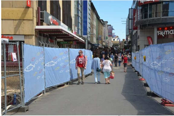
Baumaßnahme am Kleinen Kiel-Kanal, Übergang zur Fußgängerzone
