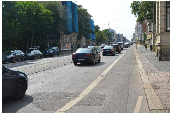
Radfahrstreifen anstelle von Kfz-Fahrspur in der Georg-Schumann-Straße Foto: Merja Spott
