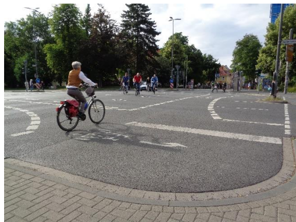
Umfangreiche Markierungen für den Radverkehr an Kreuzungen mit indirektem Linksabbiegen Foto: Manuel Weiß
