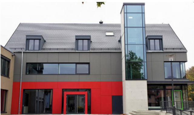
Alte Feuerwehr Gerbrunn nach der Sanierung
