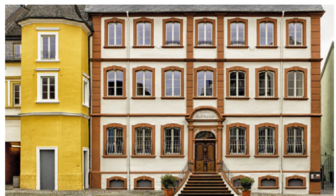
Alte Posthalterei Wittlich Foto: Architekturbüro Berdi, Bernkastel-Kues
