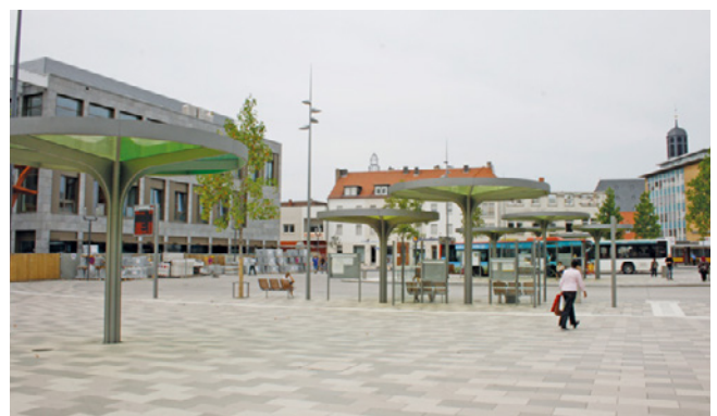
Neu gestalteter Busbahnhof Hanau
