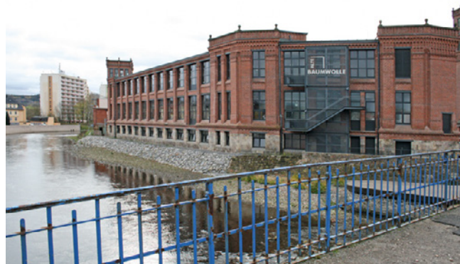
Sanierte Gebäude „Alte Baumwolle“ Flöha
