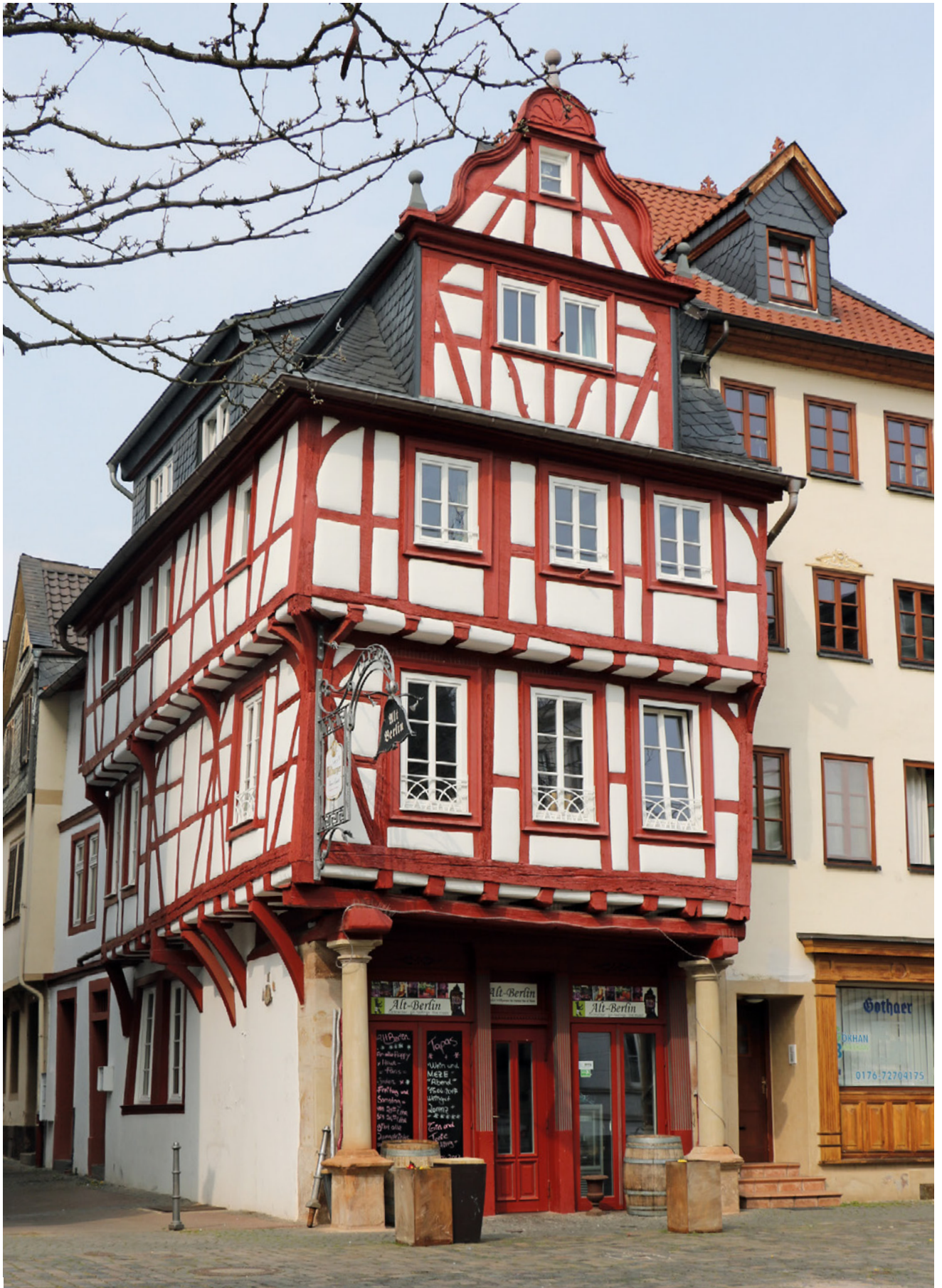
Modernisiertes Gebäude in Bad Kreuznach
