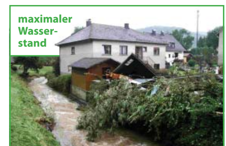
Abbildung 7 Hochwasserereignis im September 2006 im Dillgebiet
