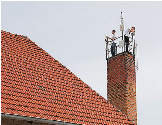
Hoch oben im Einsatz
