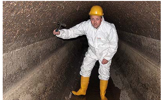
Begehbarer Mischwasserkanal in Dörentrup
