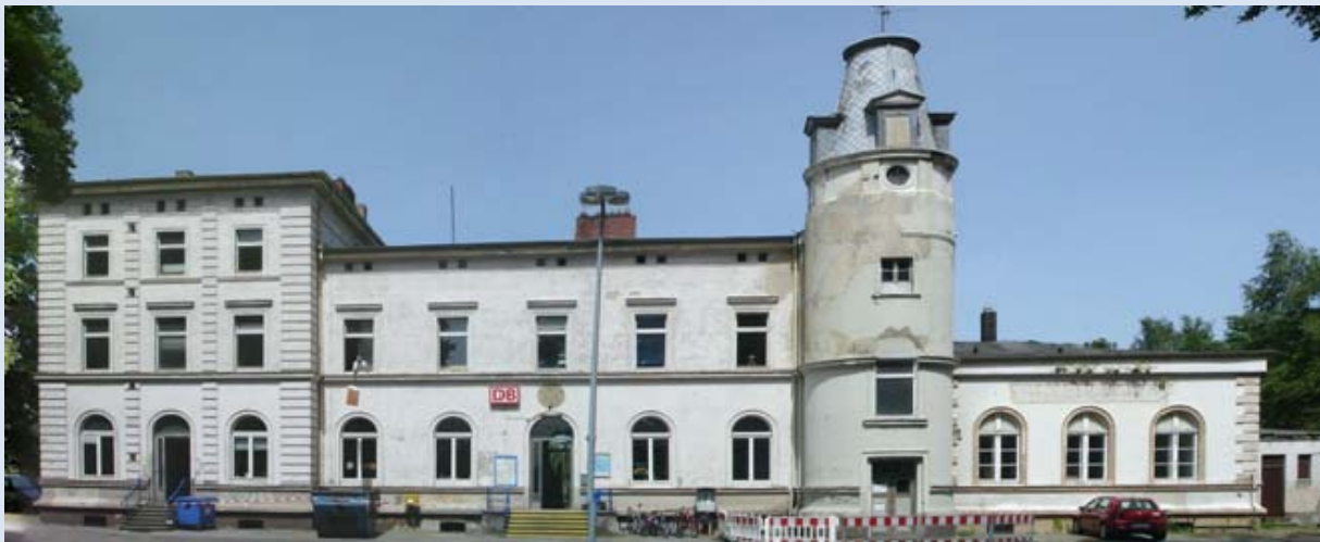
Sanierungsarbeiten am Ostbahnhof Dannenberg
