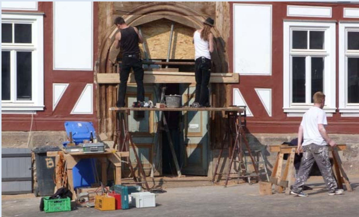
Lernbaustelle: Sanierungsarbeiten am Burgsitz Spangenberg [© Stiftung Himmelfels]
