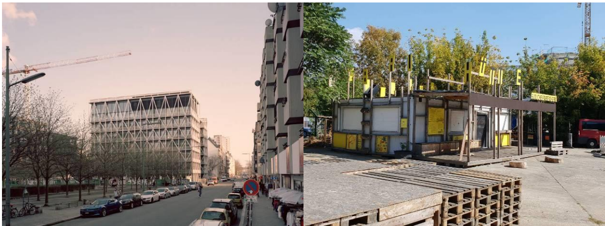
Links: Projekt auf einem der direkt verkauften Grundstücke. Architektur: E2A / Piet Eckert und Wim Eckert; Bauherrin: taz, die tageszeitung. Verlagsgenossenschaft eG; Foto: Rory Gardiner. Rechts: Die Bauhütte im Besselpark. Foto: RT.
