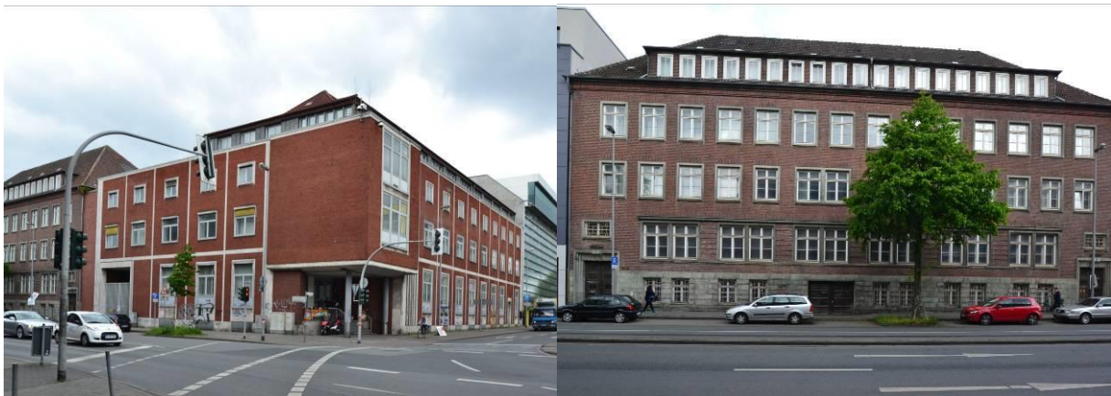
Links: Bestandsgebäude an der Ecke Von-Steuben-Straße 4–6/Herwarthstraße 8, das mittlerweile abgetragen wurde. Foto: Christa Ransmann. Rechts: Bestandsgebäude an der Von-Steuben-Straße, das erhalten wurde und Teile des neuen Hotels aufnehmen wird. Foto: Christa Ransmann.
