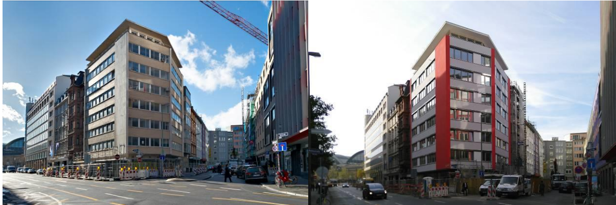
Links: Das Bestandsgebäude in der Niddastraße 57/Ecke Karlstraße, das von der Gruppe NiKa erworben wurde. Foto: Ulrich Herding für Hausprojekt NiKa. Rechts: NiKa in der Niddastraße 57/Ecke Karlstraße im Umbau. Architektur: Meides & Schoop Architekten, Foto: Ulrich Herding für Hausprojekt NiKa.
