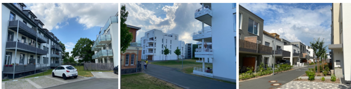
Wohnungsneubau auf Konversionsflächen in Gießen. Von rechts: Philosophenhöhe (Pendelton Barracks), Schlachthof und Bergkaserne. Quelle: IfS
