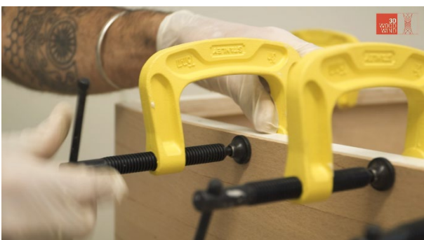
Abb. 64 Verleimung von Verbinderelementen an den Deckenmodulen
