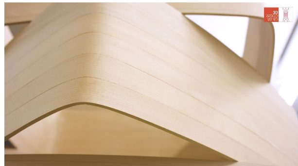
Abb. 66 Detailaufnahme gewickelte Deckenmodule
