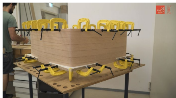
Abb. 68 Verleimung von Verbinderelementen an den Deckenmodulen
