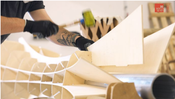
Abb. 69 Zusammenbau des Schalungselements für die Stützenbauteile
