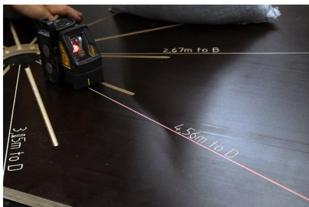
Abb. 80 Ausrichten und Positionieren der Fundamentplatten der Stützen
