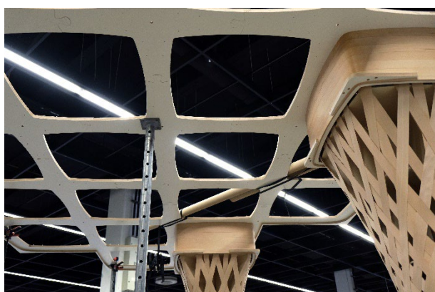
Abb. 82 Montage der Deckenbeplankung
