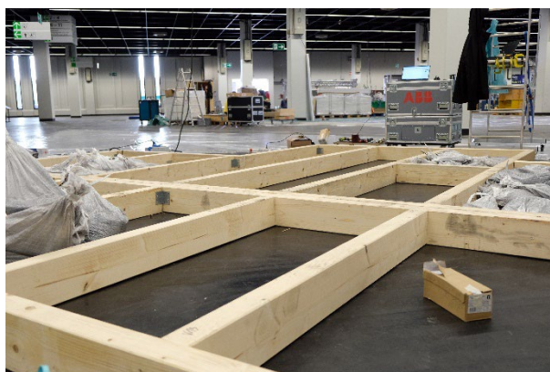
Abb. 83 Verlegen der Bodenkonstruktion aus KVH
