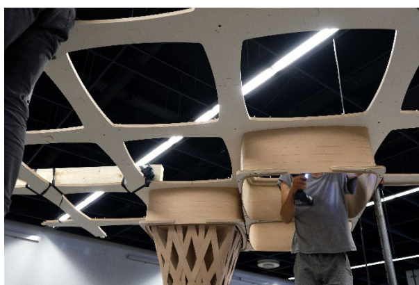
Abb. 85 Verschraubung der Deckenmodule an den Deckenplatten
