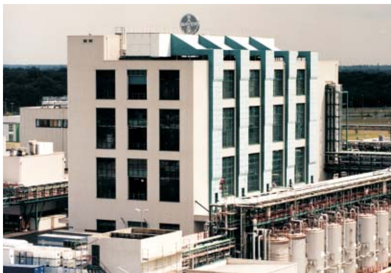
Das neue Werk der BAYER-AG in Bitterfeld
