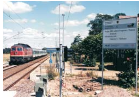
Am Bahnstreckenabschnitt Hagenow/L. – Holthusen, August 1996
