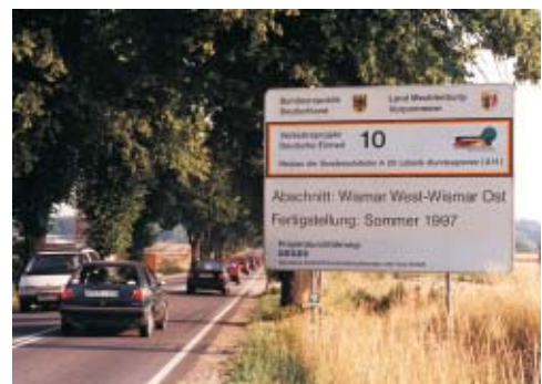
Neubau der Bundesautobahn A 20 bei Wismar, August 1995
