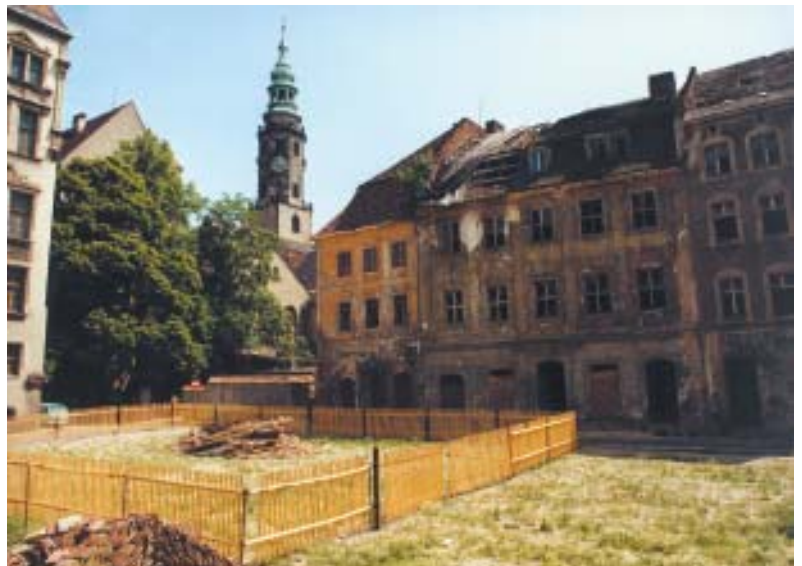
Görlitz: Bauschäden im Althausbestand
