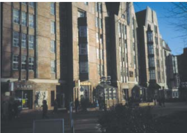
Rostock – Innenstadt: Ersatzneubau in Plattenbauweise mit Sonderelementen
