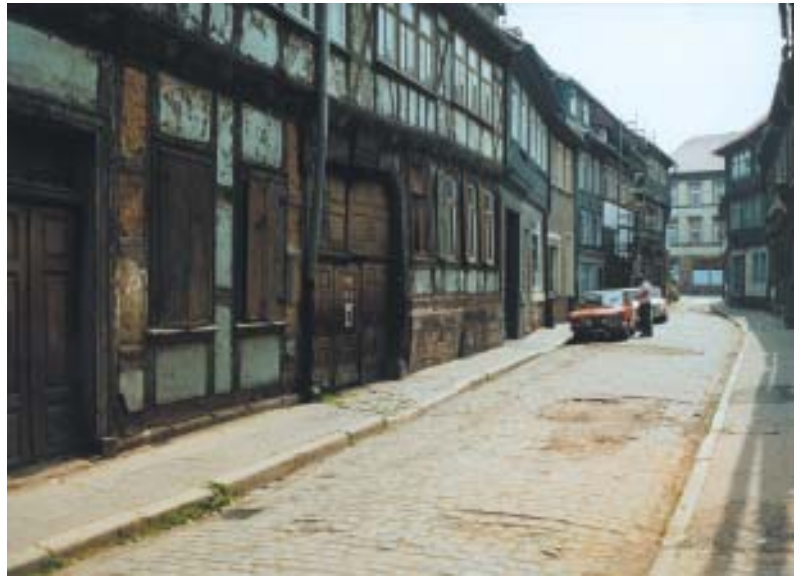
Nordhausen: Barfußergasse vor der Sanierung
