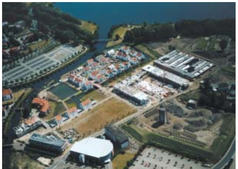
Nordhorn-Povel: Altlastensanierung und Brachenreaktivierung
