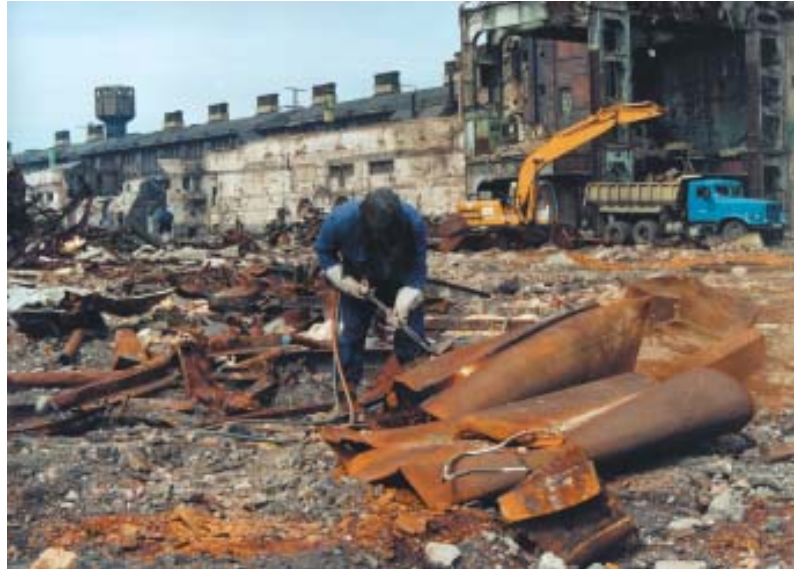
Bitterfeld: Sanierungsarbeiten bei der Chemie AG
