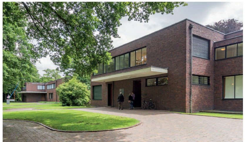
Außenansicht Haus Esters und Haus Lange
