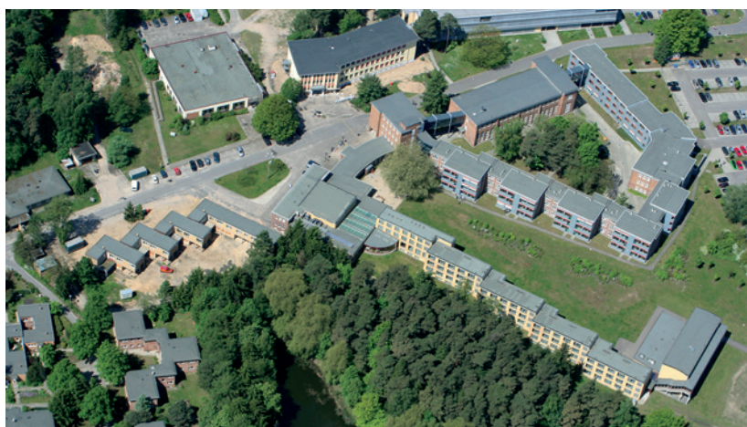
Areal Bauhaus Denkmal Bundesschule Bernau (vor Sanierung der Außenanlagen)
