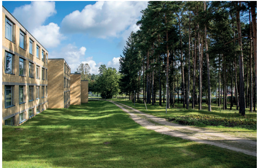
Außenanlagen Bundesschule Bernau
