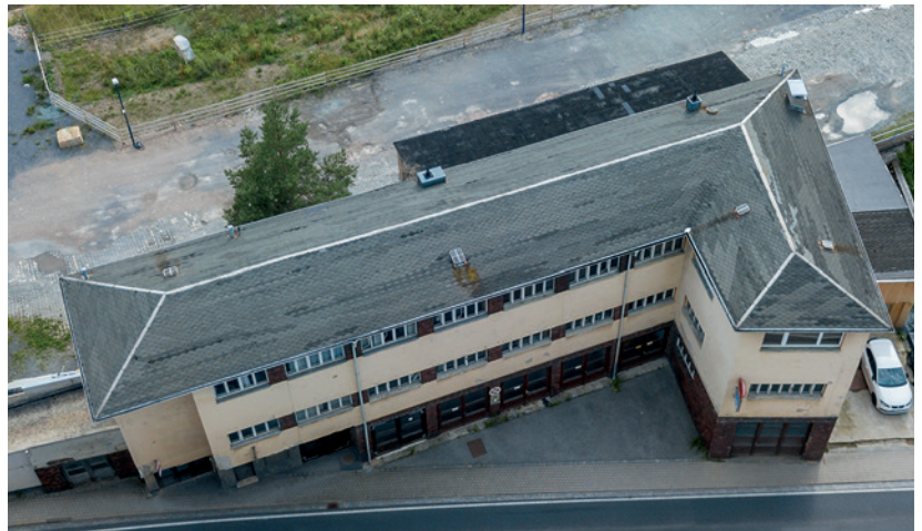
Itting-Garagen vor der Sanierung
