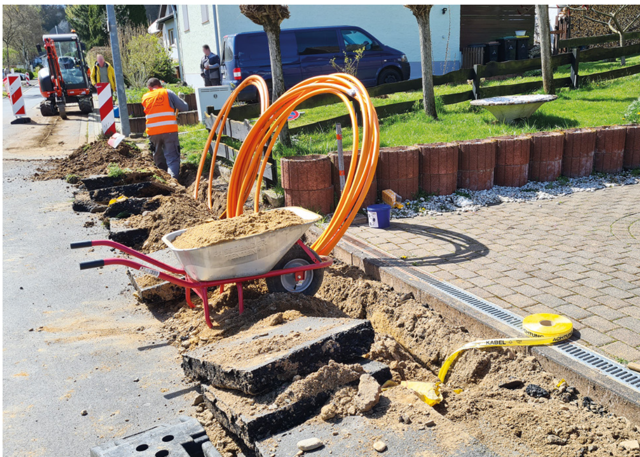
Glasfaserausbau in Niederbachem
