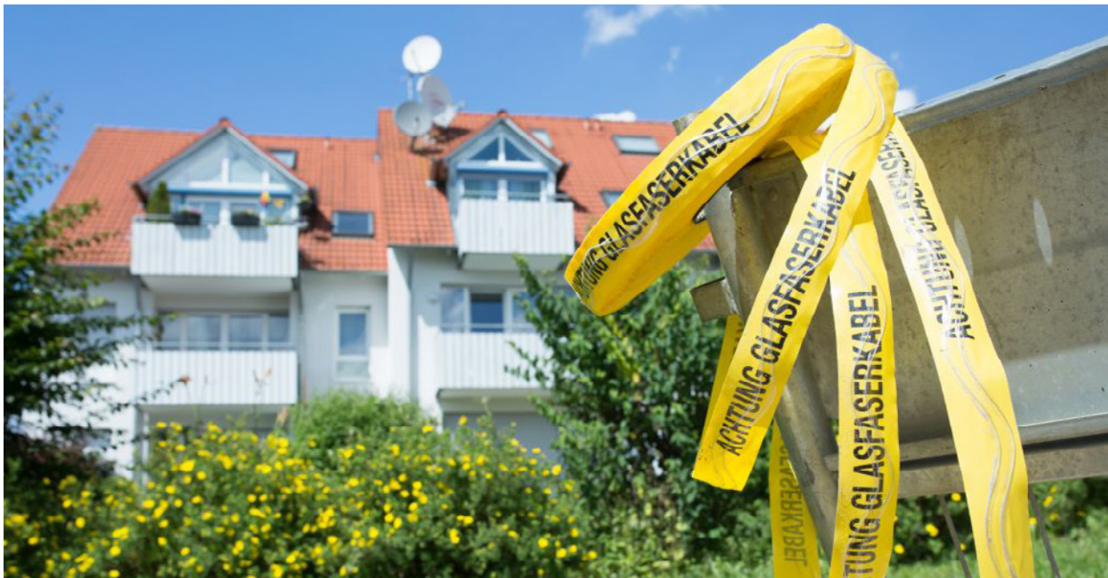
Bauarbeiten im Gebiet des Projektes KommPaktNet (Ulm)
