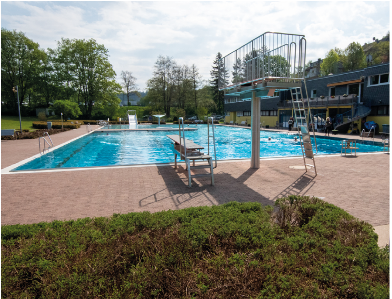
Energetisch teilsanierte Umkleidegebäude im Freibad Kaan-Marienborn, gefördert im Rahmen des Investitionspakts Sportstätten, Mai 2022
