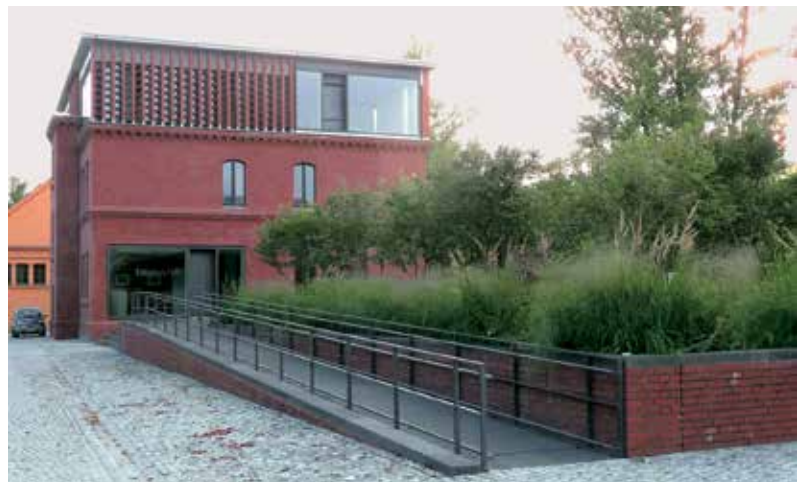
Rampenanlage – Bundesstiftung Baukultur, Potsdam
