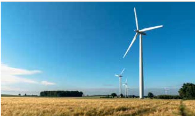
Windenergie ist von großer Bedeutung für die Energiewende
