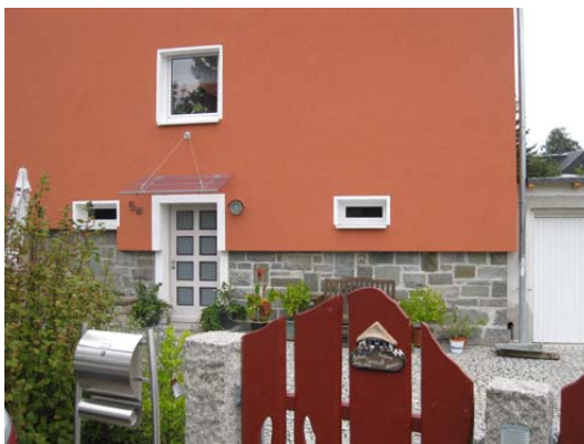
Generationenwechsel mit Umbaumaßnahmen
