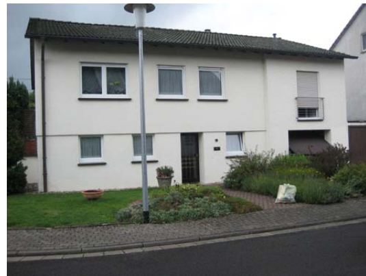
Frei stehender Einfamilienhaustyp mit hoher Akzeptanz
