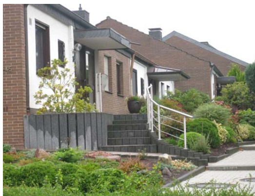
Für Ältere ungeeignete Eingangssituation
