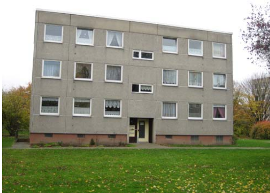
Dreigeschossige Solitärbauten, unsaniert
