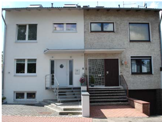
Doppelhaus mit und ohne Modernisierung
