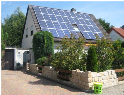
Energiemaßnahmen als Nachrüstung
