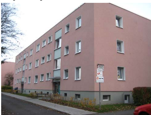
Typische Zeilenbauten nach Sanierung
