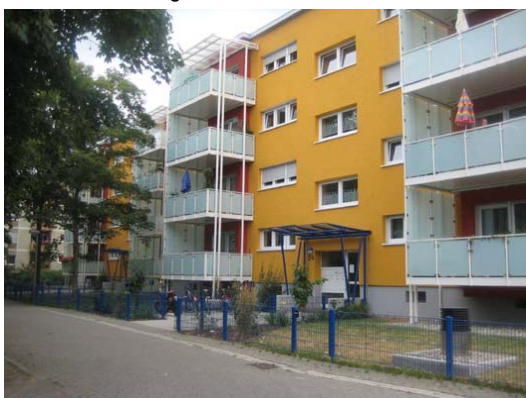
Aufwendige Sanierung im Geschoss
