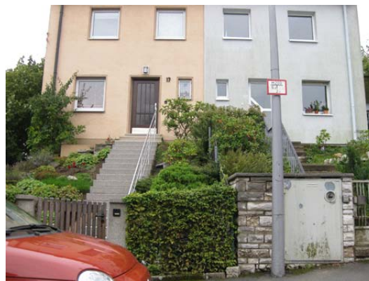
Altengerechte Nachbesserungen (Geländer)
