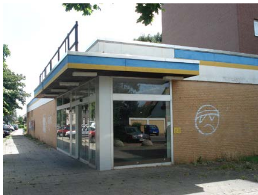
Leer stehende Ladenfläche
