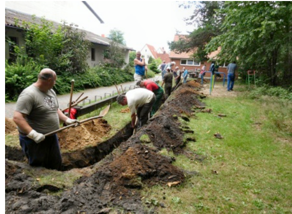
Ein Großteil der Dorfgemeinschaft hilft beim Ausheben der Gräben mit. Foto: Reimund Jochheim
