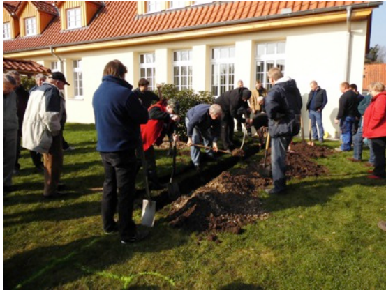
Durch den gemeinsamen Arbeitseinsatz können die Haushalte ans Breitbandnetz angeschlossen werden. Foto: Heinz Luikenhuis
