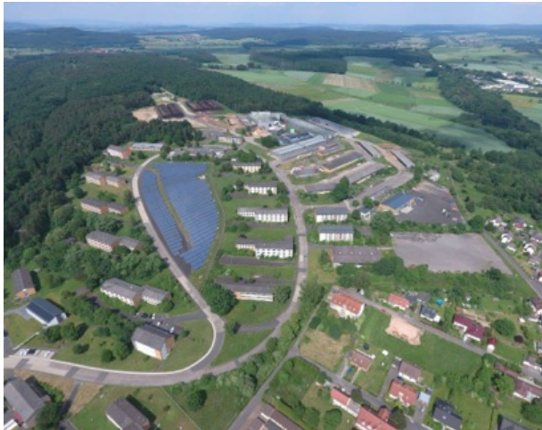
Das Solarkraftwerk liefert Energie für die umliegenden Häuser. Foto: Energiegenossenschaft Schwalm-Knüll eG
