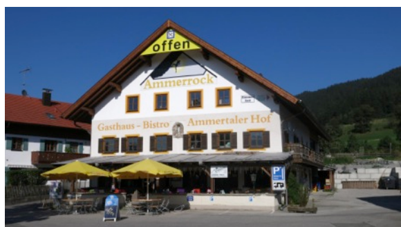
Der sanierte Ammertaler Hof. Foto: Viola Erhard
