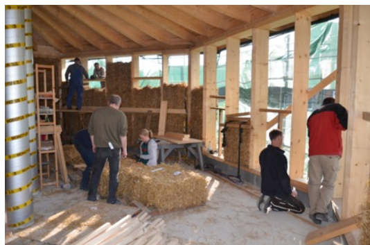
Beim Errichten des Strohhallenhauses wurde selbst Hand angelegt. Foto: Henning Austmann
