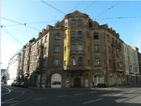
Abb. 7: Leipzig Demmeringstr. 21 vor der Fassadensanierung, © HausHalten e.V.
