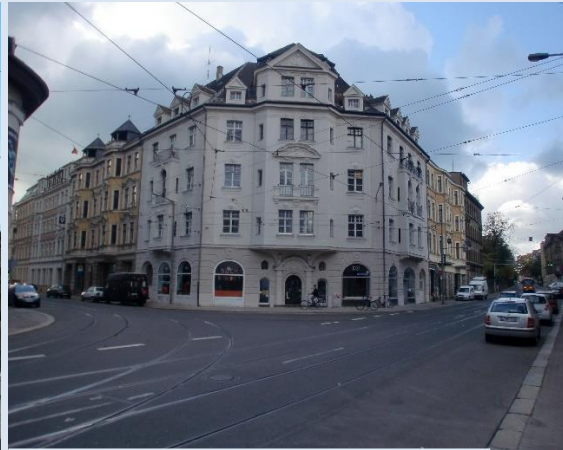
Abb. 6: Leipzig Demmeringstr. 21. nach der Fassadensanierung, © HausHalten e.V.
