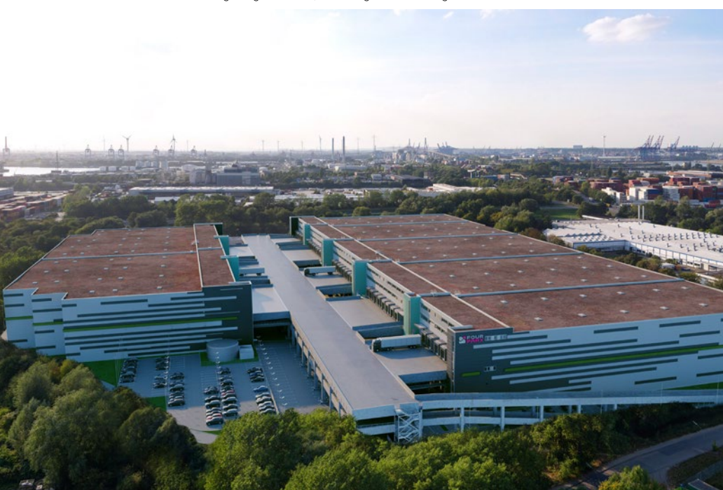
Abb. 128: Zweistöckige Logistikhallen, Hamburg-Wilhelmsburg
