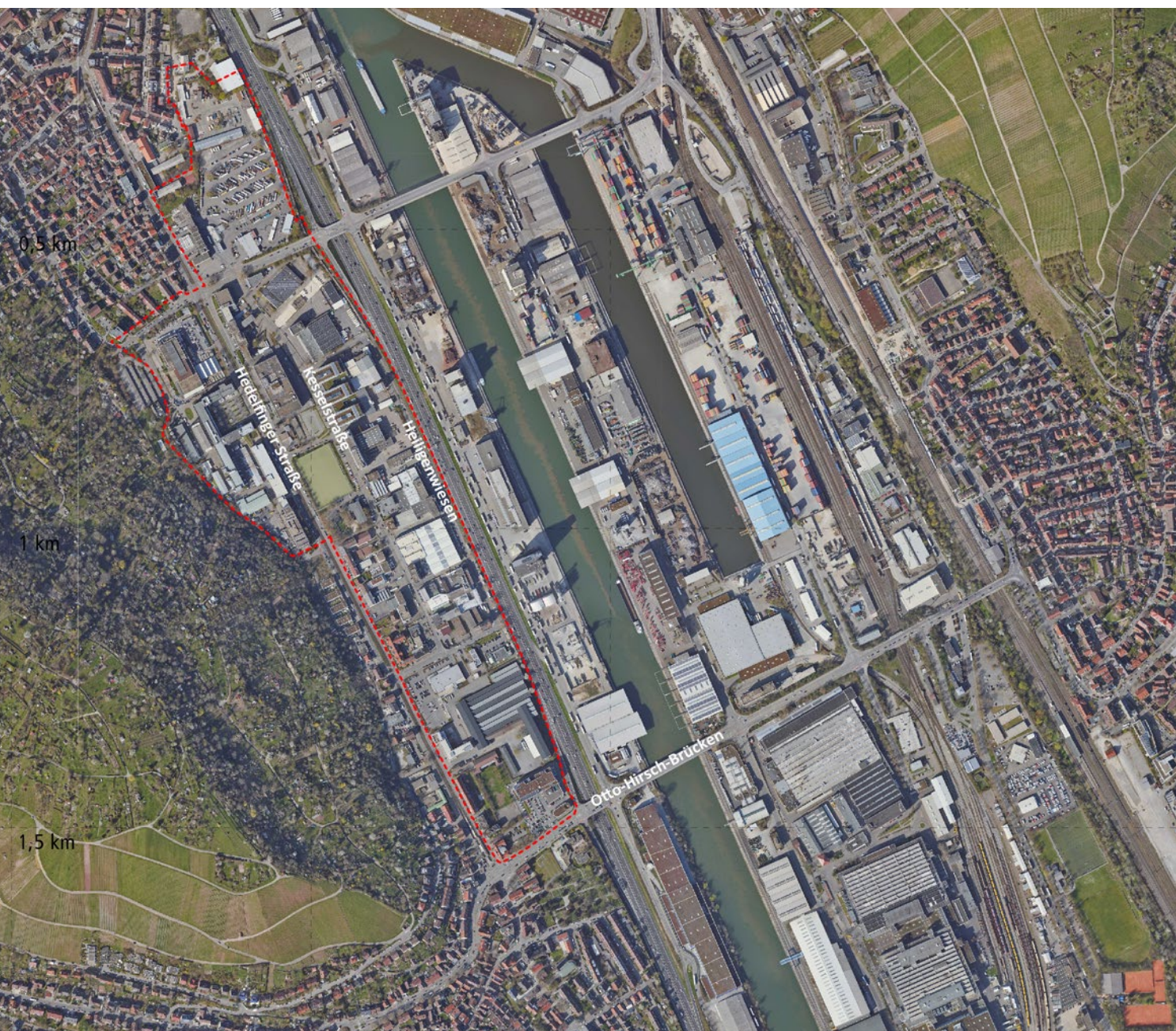
Abb. 54: Gewerbegebiet Hedelfinger Straße – Luftbild
