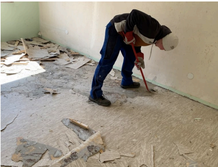
Abbildung 18: Herausbrechen von Belagsstücken 32
