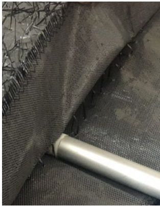
Aufziehen des Textilvermögens mit Alustange als Hilfsmittel
