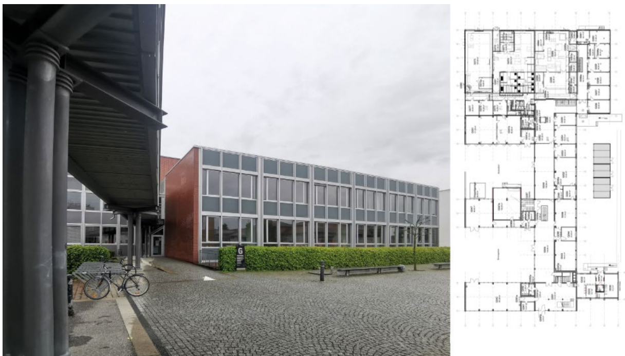
Abbildung 38: Virtueller Rundgang durch ein Bestandsgebäude, Darstellung einer Einzelansicht.
