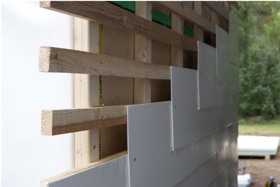
Abb. 19: Unterkonstruktion und Schindeln
