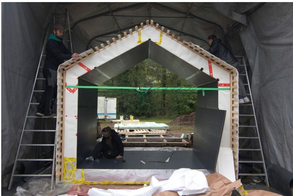
Abb. 20: Dachdeckung und Innenbekleidung
