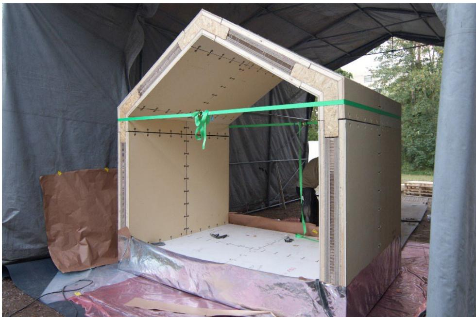
Abb. 18: Die fertige Tragkonstruktion
