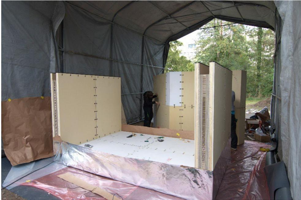
Abb. 15: Wandelemente und Sockelabdichtung
