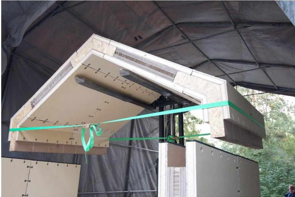
Abb. 17: Einsetzen der Dachkonstruktion
