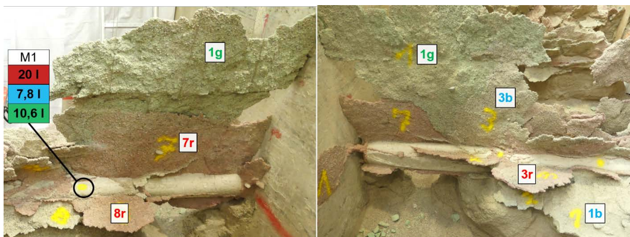
Abb. 4.26: Großflächige Plattenstrukturen im hinteren Bereich von Rohr 1
