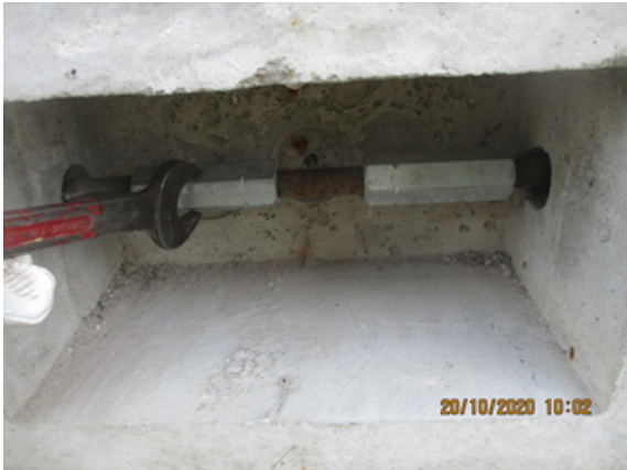
Bild 280 Rückbau der Fundamentebene - Ablösen der Spannglieder
