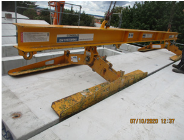
Bild 270 Rückbau des OG - Fortsetzung des Rückbaus der Deckenplatten über OG
