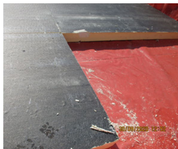
Bild 257 Rückbau des Dachaufbaus Demontage der gleichstarken Dachdämmung
