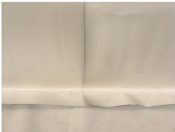
Bild 175 Bahnteilung 15 cm Überlappung-Attikaabdichtung
