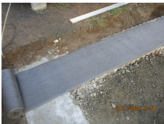
Bild 289 Verlegen der Abdichtungsfolie - Montage der Fundamentebene
