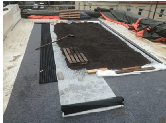
Bild 326 Forstsetzung- Aufbau des Gründaches
