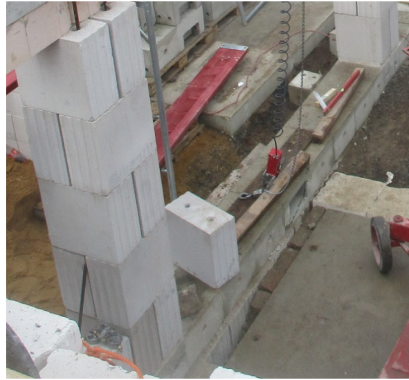
Bild 301 Vermauern der KS-Pfeiler
