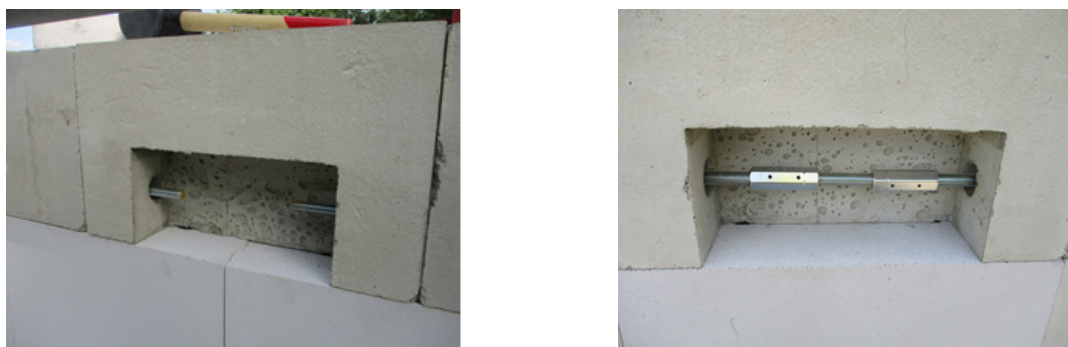
Bild 140 Vorspannung jedes Abschnitts des Ringankers im EG - Anwendung von 2 Spannschlössern M16 & Linksgewinde M16
