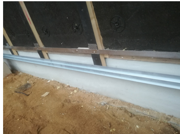
Bild 330 Remontage des Fassadensystems- Anbringen der Dichtungsbahnen an den Holzlatten
