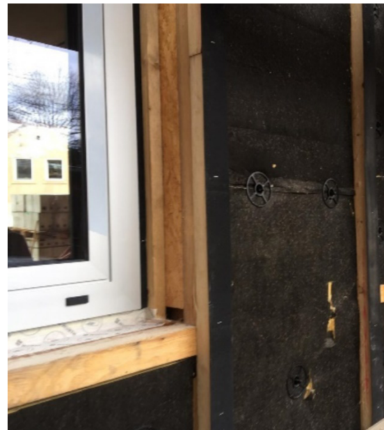
Bild 334 Positionierung Fenster
