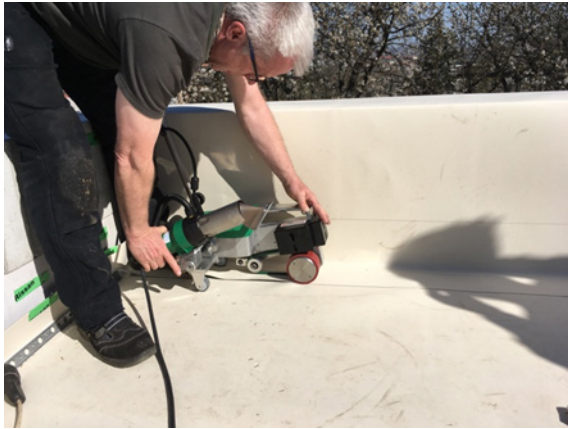
Bild 177 Schweißen der Attikaabdichtung mit der Dachdichtung an der 15 cm Überlappung mit Schweißautomat
