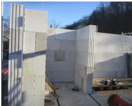
Bild 310 Vermauern der verkürzten Aussteifungswände im OG nach dem gleichen Bauprinzip
