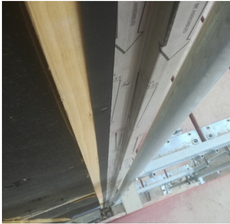
Bild 331 Remontage des Fassadensystems- Montage der Eckprofile und Startprofile
