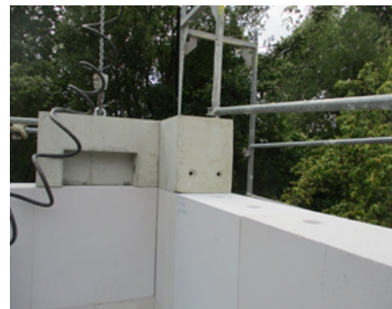
Bild 138 Beginn der Montage des Ringankers im EG mit einem Eckstein - Einfädeln der Spannglieder M20 - Versetzen der Ringankersteine mittels Mauerkrans durch Anwendung der Hülsenschrauben
