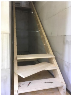
Bild 230 Einbau der Holzstufen –
