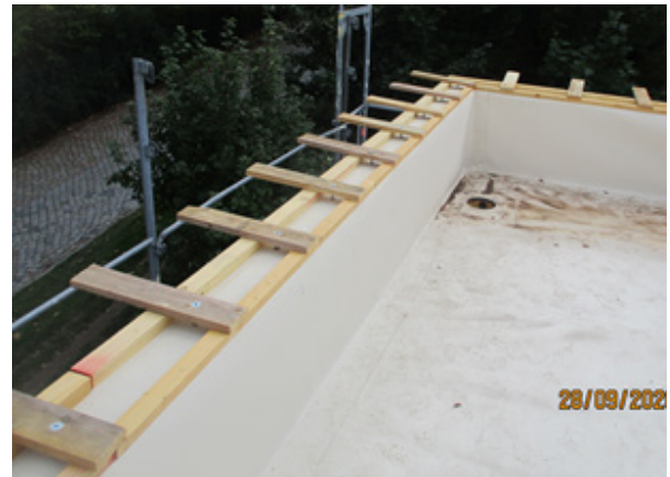
Bild 251 Rückbau des Attikaaufbaus – Demontage der Holzlatten
