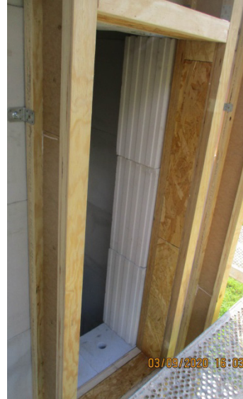
Bild 221 Montage der Fensterleibungen durch Abdeckung der Stegträger mit OSB-Platten
