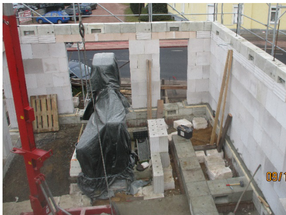
Bild 304 Montage des Ringankers im EG - Montage der Ringankersteine
