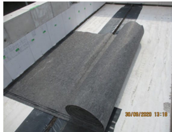
Bild 259 Rückbau des Dachaufbaus - Rückbau der Vliesschicht
