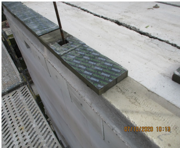
Bild 266 Rückbau des Attikageschosses - Rückbau der Schaumglas-Plattenreifen
