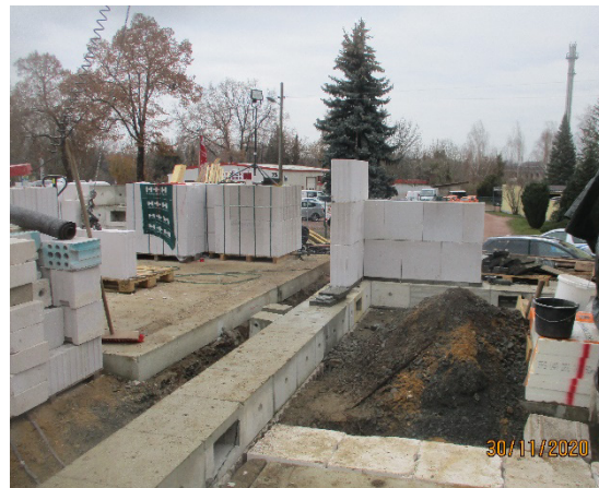
Bild 295 Vermauern der KS-Wände im EG
