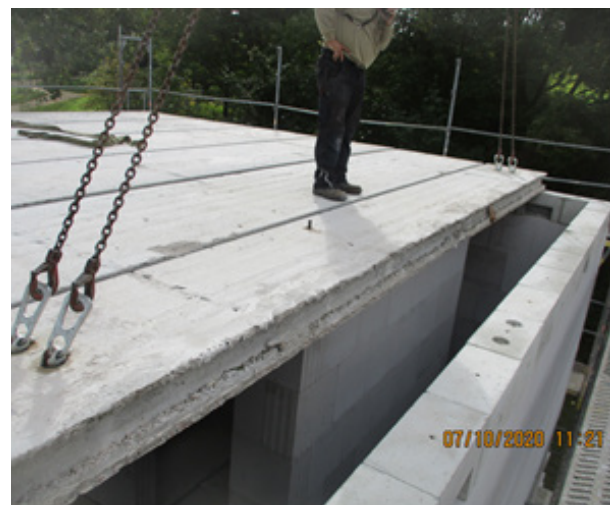
Bild 269 OG-Rückbau der Deckenplatten über OG- Demontage der einzelnen Spannbeton-Platten
