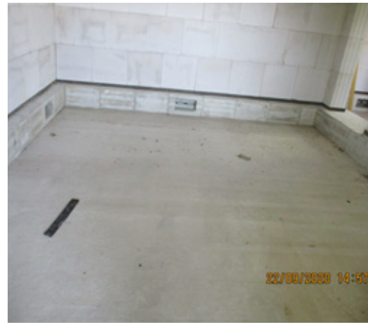
Bild 245 Rückbau des Fußbodenaufbaus - Endzustand
