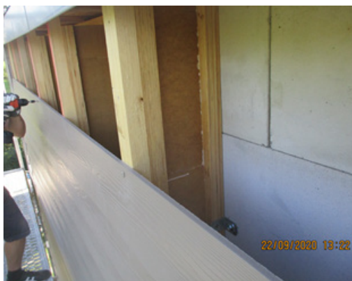
Bild 232 Demontage der Eternitpaneele - ab dem Attikabereich
