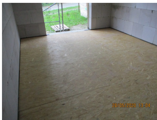
Bild 212 Fertigstellung des Fußbodenaufbaus - ohne Belag
