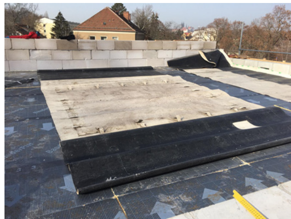
Bild 320 Verlegung der Dämmplatten und Gefälledämmung
