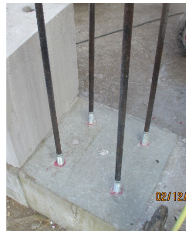
Bild 299 Einschrauben der vertikalen Spannglieder für die KS-Pfeiler
