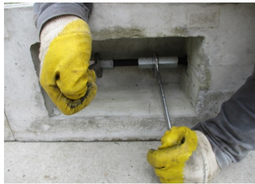
Bild 121 Verspannen der Fundamentstreifen am Spannstein durch Spannschlösser
