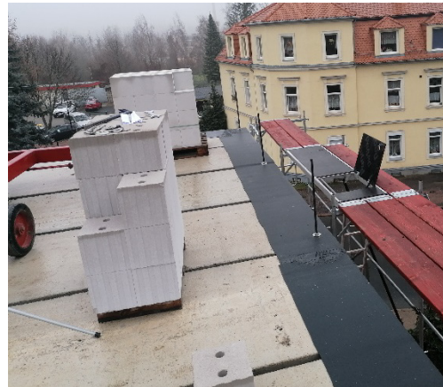
Bild 313 Verlegen der Spannbetondeckenplatten über OG - Abdichtungstreifen unter dem Attikageschoss
