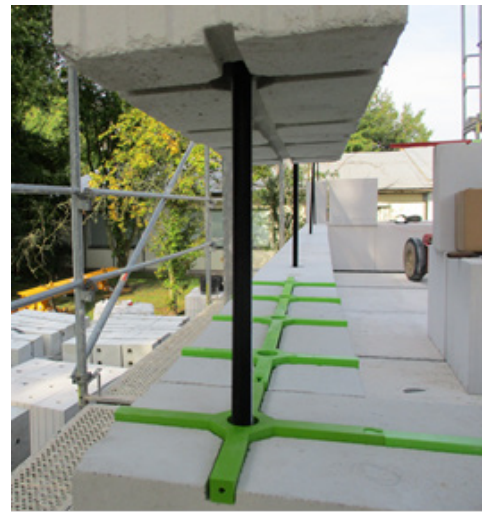
Bild 136 Fortsetzung des Aufmauerns der gefrästen KS-Steine im EG
