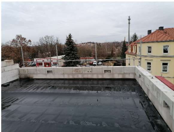
Bild 319 Verlegung der Dampfsperre aus angeschweißten PVC-Bahnen
