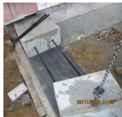
Bild 290 Verlegen der Fundamentsteine mit der horizontalen Verspannung – Montage der Fundamentebene
