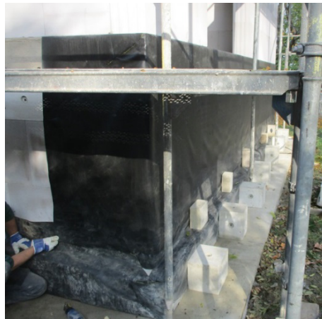
Bild 130 Anschweißen der oberen Abdichtungsfolie mit der unteren zur Abdichtung der Unterkellerung - ausreichende Feuchteisolierung
