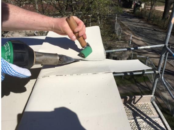
Bild 181 Attika-Eckabdichtung Anschweißen des Passstücks
