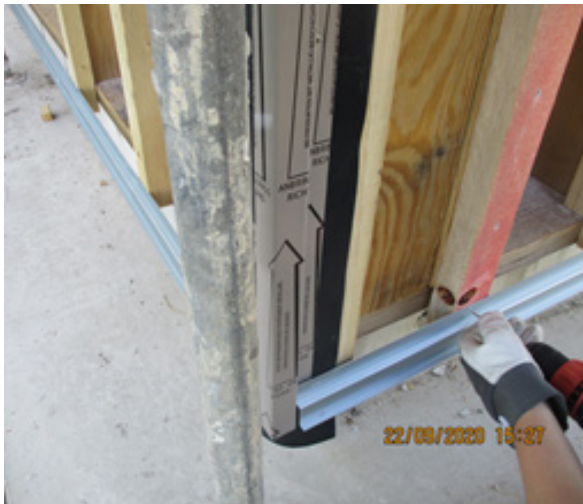
Bild 234 Demontage der Systemprofile
