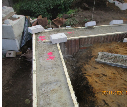
Bild 288 Ausgleichschicht mit Ausgleichmörtel zum Toleranzausgleich für die Trockenfundamente
