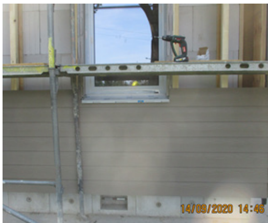
Bild 228 Montage des Fassadensystems des Fassadensystems links - Montage der Profile und Passstücke in die Fenster- und Türlaubungen rechts
