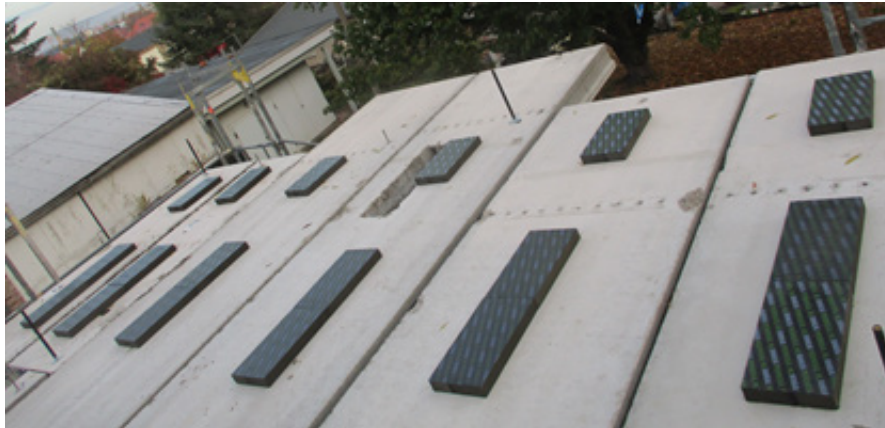
Bild 148 Anordnung der Auflagerpunkte zur Verteilung der Lasten
