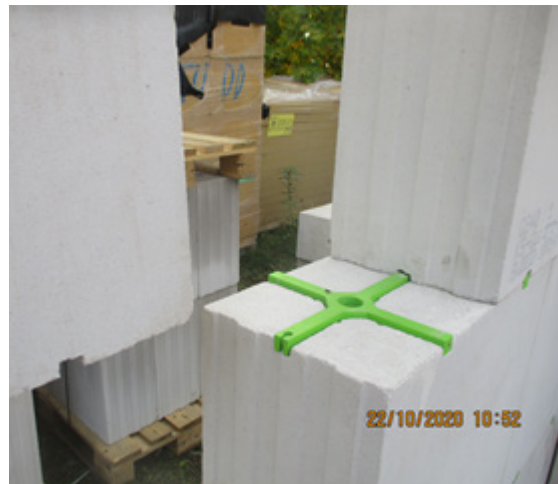
Bild 279 zerstörungsfreier Rückbau der KS-Modulsteine mit den Kreuzverbindern
