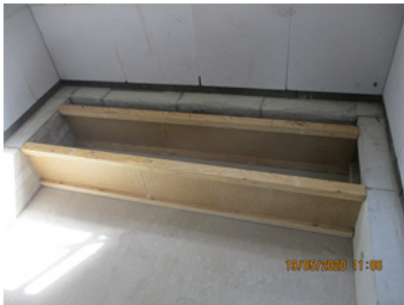
Bild 207 Verlegen der Holzstegträger im kleinen Raum - Fußbodenaufbau
