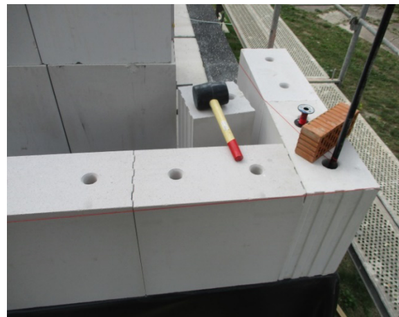
Bild 133 Anwendung von Mauerschnur und Gummihammer
