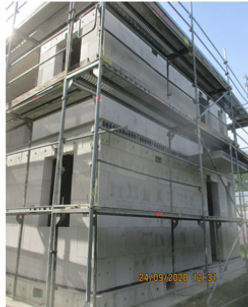
Bild 239 Endzustand der Demontage der Fassade
