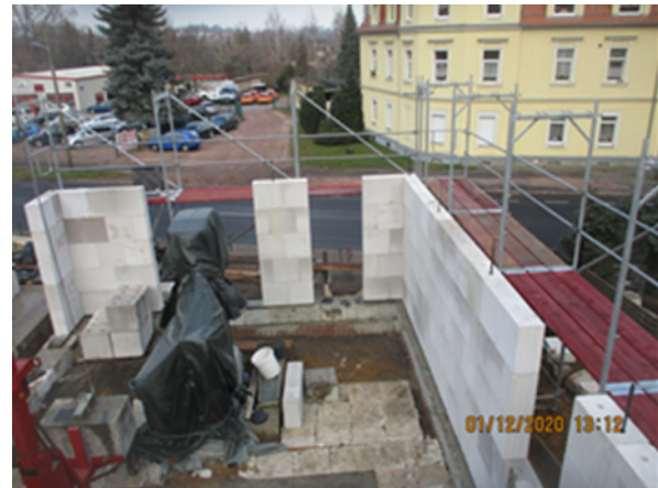
Bild 297 KS-Wände im EG nach Veränderung der Bauform
