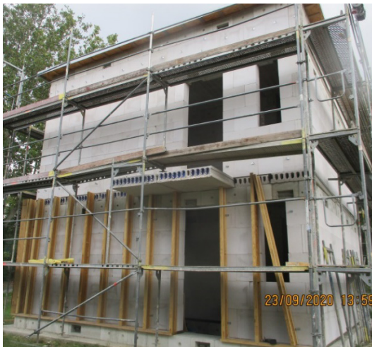
Bild 236 Demontage der Holzlatten, Bohlen und Stegträger
