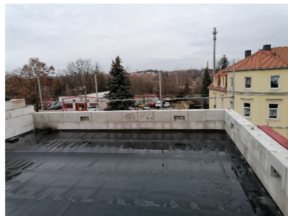
Bild 317 Errichtung des Attikageschosses - Rohbaufertigstellung
