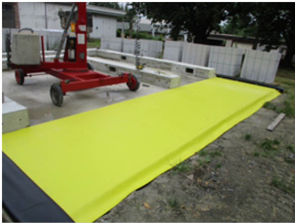
Bild 122 Verlegen der Abdichtungsfolie vor dem Verlegen der Fundamentsteine
