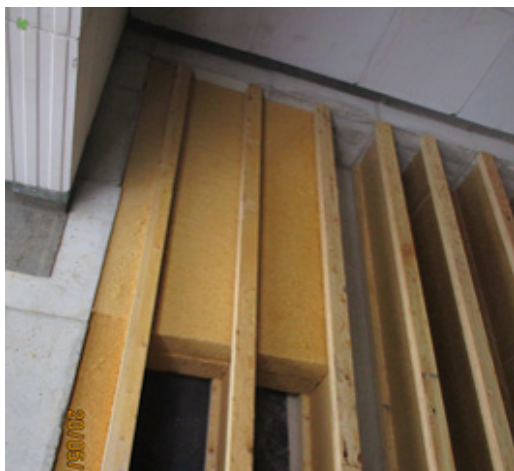
Bild 209 Verlegen der Dämmstreifen zwischen den Profilträgern - Fußbodenaufbau
