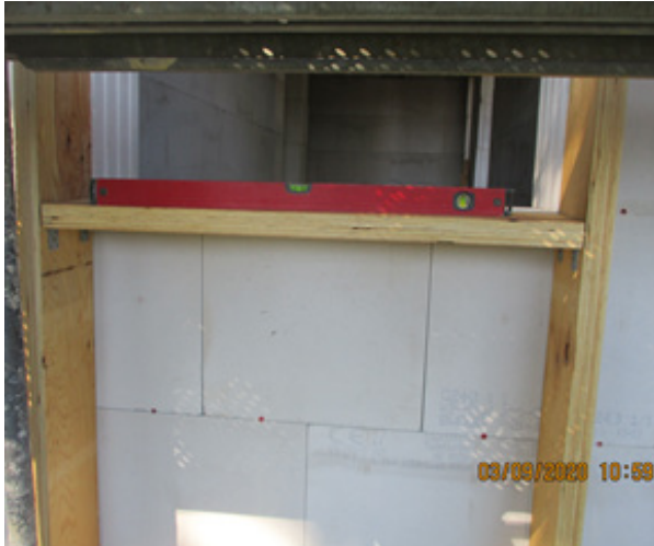
Bild 220 Montage der Fensterleibungen durch Furnierschichtholz (STEICO LVL R)
