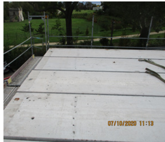
Bild 267 Rückbau des Attikageschosses - 100% Demontierbarkeit
