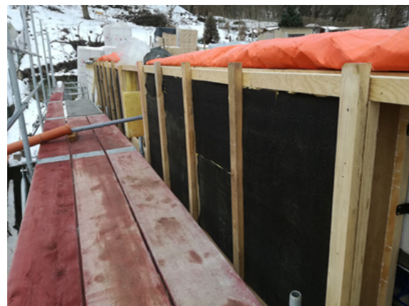
Bild 328 Forstsetzung- Remontage der Holzlatten an den Stegträgern als Grundlage zur Montage der Eternitplatten- Verlegen der Fassadendämmung zwischen den Stegträgern
