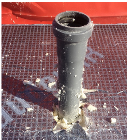
Bild 186 Einbettung des Entlüftungsröhr in die Gefälledämmung
