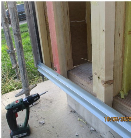
Bild 226 Montage des Fassadensystems - Montage der Startprofile
