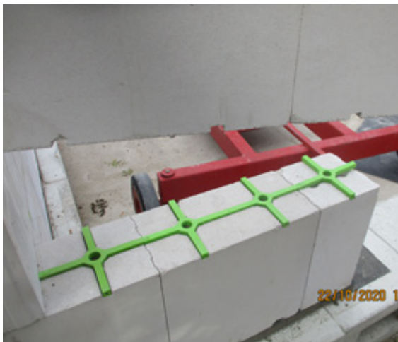
Bild 278 Rückbau des EG - Rückbau der KS-Modulsteine mit den Kreuzverbindern
