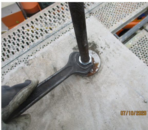
Bild 268 Rückbau des OG - Rückbau der Deckenplatten über OG – Ablösung der Vertikalspannung
