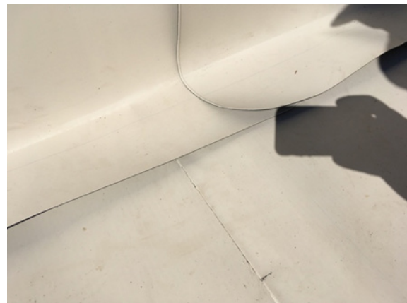
Bild 176 Bahnteilung Vorbereitung Schweißen: Ausrunden der Ecken
