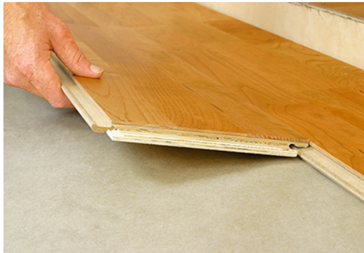
Bild 86 Bodenbelag-Laminat
