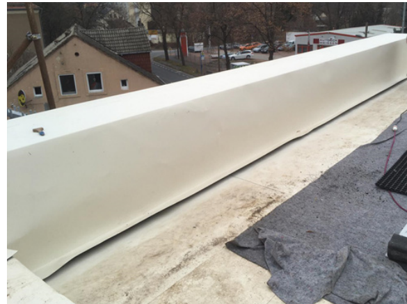
Bild 324 Verlegung der Abdichtungsbahnen über den Attikarohbau
