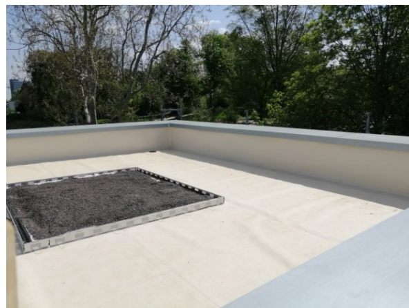
Bild 206 Fertige Attika
