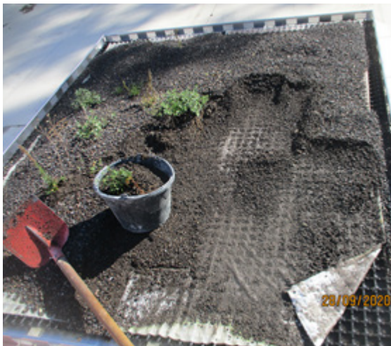
Bild 252 Rückbau des exemplarischen Grün-dachs - Abtragung der Vegetationstragschicht
