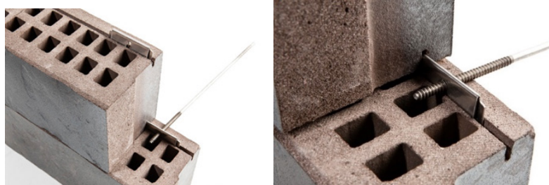
Bild 55 Herkömmliche Befestigung mit Mauerwerksankern
