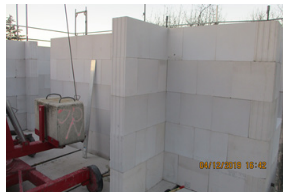
Bild 152 Fertigstellung der Mauerwände aus KS-Quadro-Steinen im OG nach der Trockenbauweise mittels Mauerkranes
