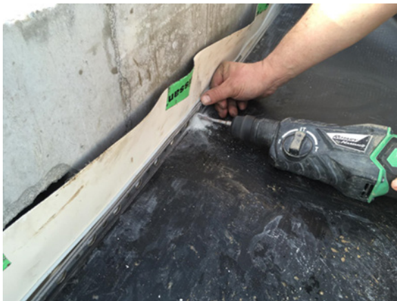
Bild 323 Befestigung der Abdichtungsbahnen mit einer Befestigungsschiene am Attikaunterkante
