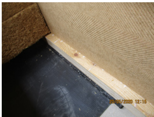
Bild 210 Verlegen der Dampfbremse (bzw. Abdichtung gegen aufsteigende Feuchte) - Fußbodenaufbau exemplarisch
