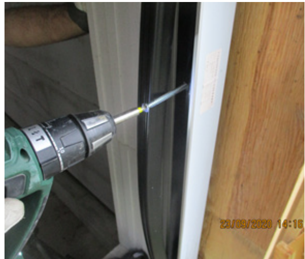
Bild 235 Demontage des Fensters
