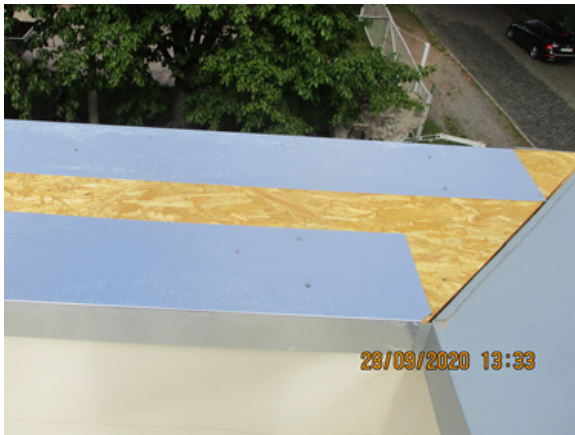
Bild 250 Rückbau des Attikaaufbaus – Demontage der Unterbleche und nachfolgend der OSB-Platten
