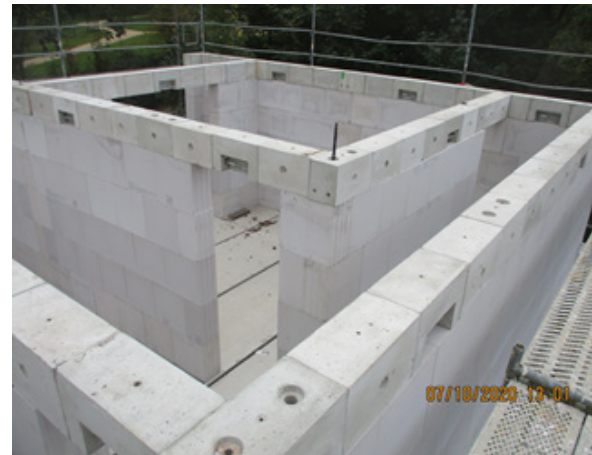
Bild 271 Rückbau des OG - Endzustand des Rückbaus der Deckenplatten über OG
