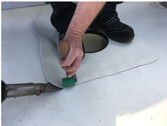
Bild 190 Vollständiges Anschweißen der Dichtmanschette von oben an die Dichtbahn
