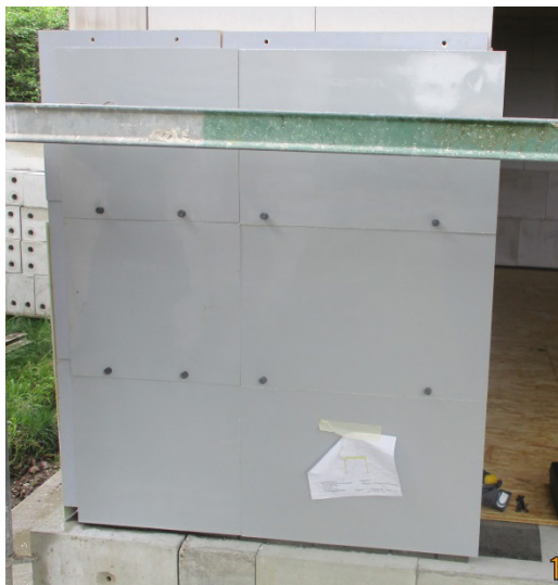
Ansicht der montierten Vakuumpaneele von Variotec – 5 0 cm Dämmsystem
