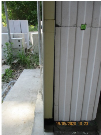
Bild 215 Seitliche Ansicht der entwickelten Vakuumpaneele von Variotec – 5 cm Dämmsystem
