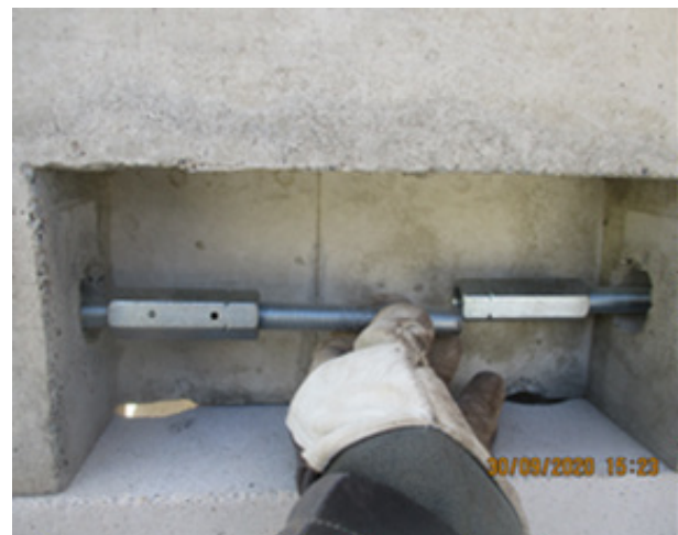
Bild 263 Rückbau des Attikageschosses - Rückbau des Ringankers-Ablösung der Horizontalspannglieder
