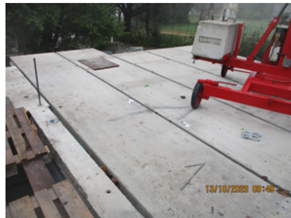
Bild 275 Fertiger Rückbau des OG
