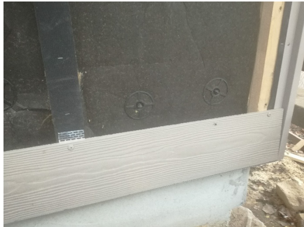
Bild 332 Remontage des Fassadensystems- Montage der Eternitplatten
