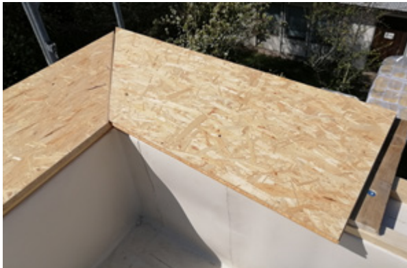
Bild 199 Verlegen der OSB-Holzplatten über die Querträger und Befestigung mittels Holzschrauben
