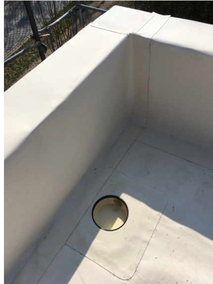
Bild 182 Fertiggestellte Eckausbildung und Einbindung des Entwässerungstopfes
