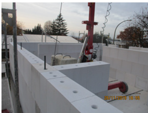
Bild 152 Fertigstellung der Mauerwände aus KS-Quadro-Steinen im OG nach der Trockenbauweise mittels Mauerkranes
