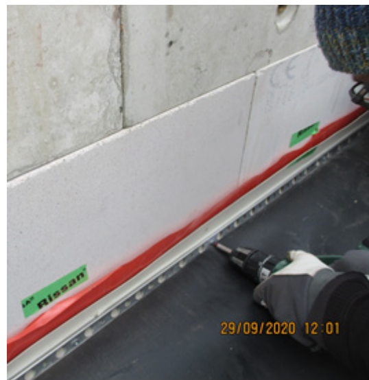
Bild 255 Rückbau des Dachaufbaus - Demontage der FPO-Abdichtungsbahnen - Abschrauben der Befestigungsleiste
