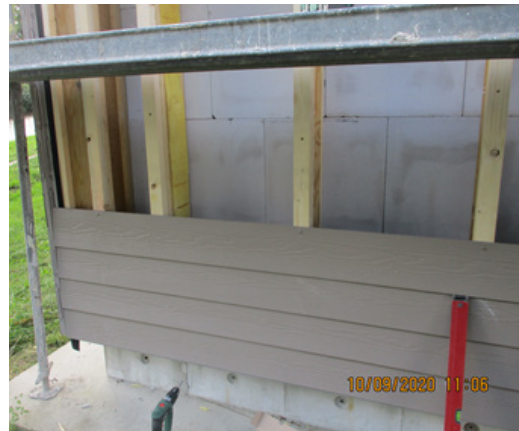
Bild 227 Montage des Fassadensystems - Cedral Lap
