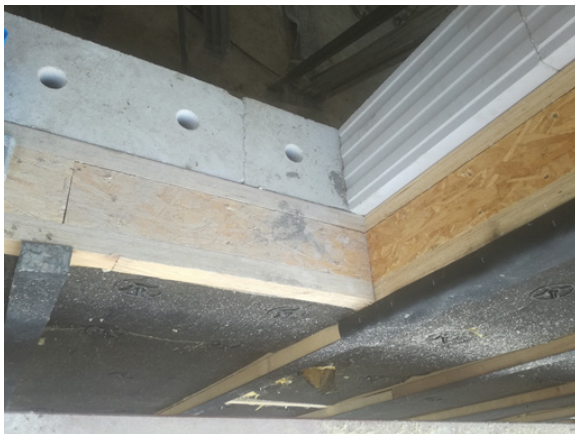
Bild 329 Fassaden-Remontage: Montage der Fensterlaibungen durch Er-schließung der Stegträger mit OSB-Platten
