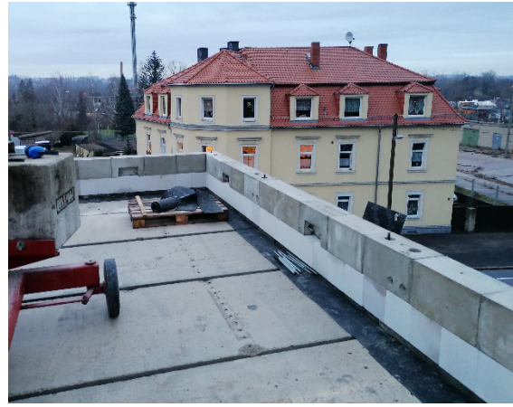
Bild 315 Errichtung des Attikageschosses - 25 cm KS-Reihe
