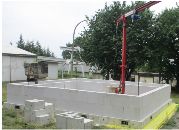
Bild 124 Aufmauern der KS-Wände der reduzierten Unterkellerung
