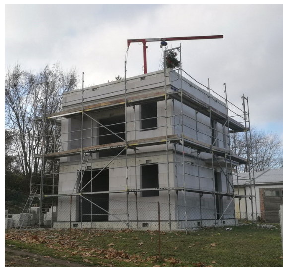
Bild 156 Fertigstellung des Rohbaus des Versuchshauses- Isometrie links und Hauptfassade (Seite der Stadtgutstraße) rechts
