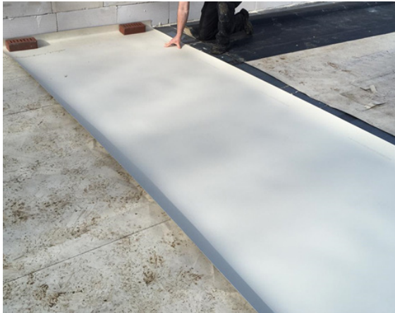
Bild 321 Verlegung einer vierten Abdichtungsbahn zur Anpassung der Längenänderung des Forschungsgebäudes
