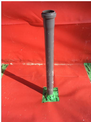
Bild 184 Entlüftungsröhr am Durchstoßpunkt Dampfbremse mit Dampfsperr-Klebeband eingebunden
