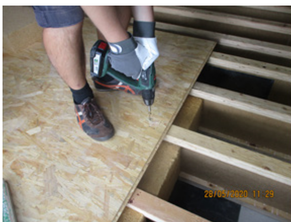
Bild 211 Verschrauben der OSB-Platten an den Stegträgern - Fußbodenaufbau
