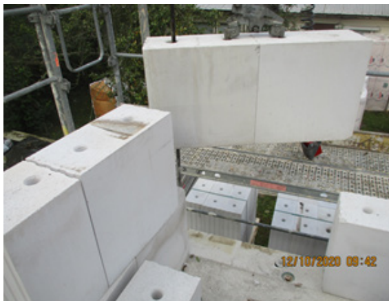
Bild 274 Demontage des OG - Rückbau der KS-Wände
