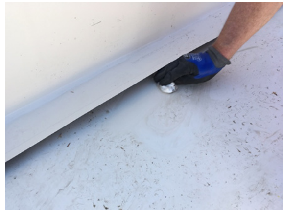
Bild 170 Gründliche Reinigung der zu verschweißenden Nahtstellen mit Reinigungsmittel
