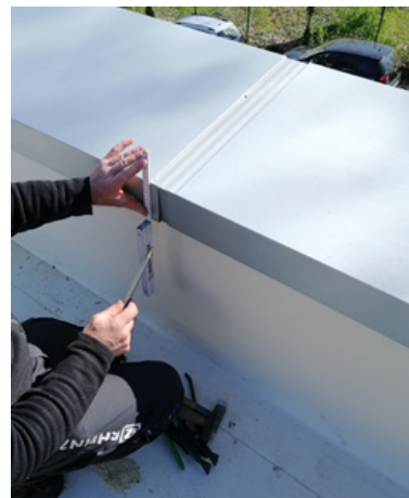
Bild 202 Befestigung der oberen Zinkbleche an den Verbindungselementen
