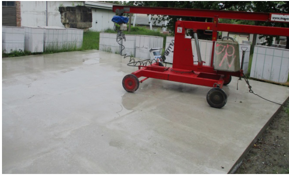
Bild 118 Mauerkran zum Verlegen der Fundamentsteine
