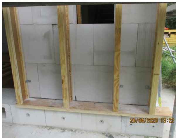
Bild 219 Montage der Stegträger - Schwelle aus Brettschichtholz als Abfangung im Erdgeschoss
