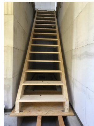
Bild 231 Fertigstellung der demontierbaren, wiederverwendbaren Treppenkonstruktion
