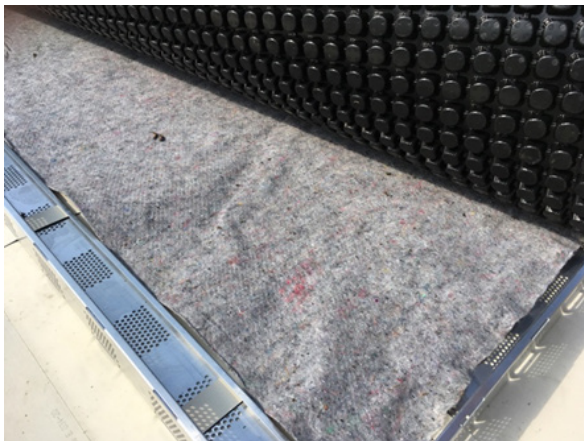
Bild 193 Schutzvliesmatte als erste Lage unter dem Gründachaufbau
