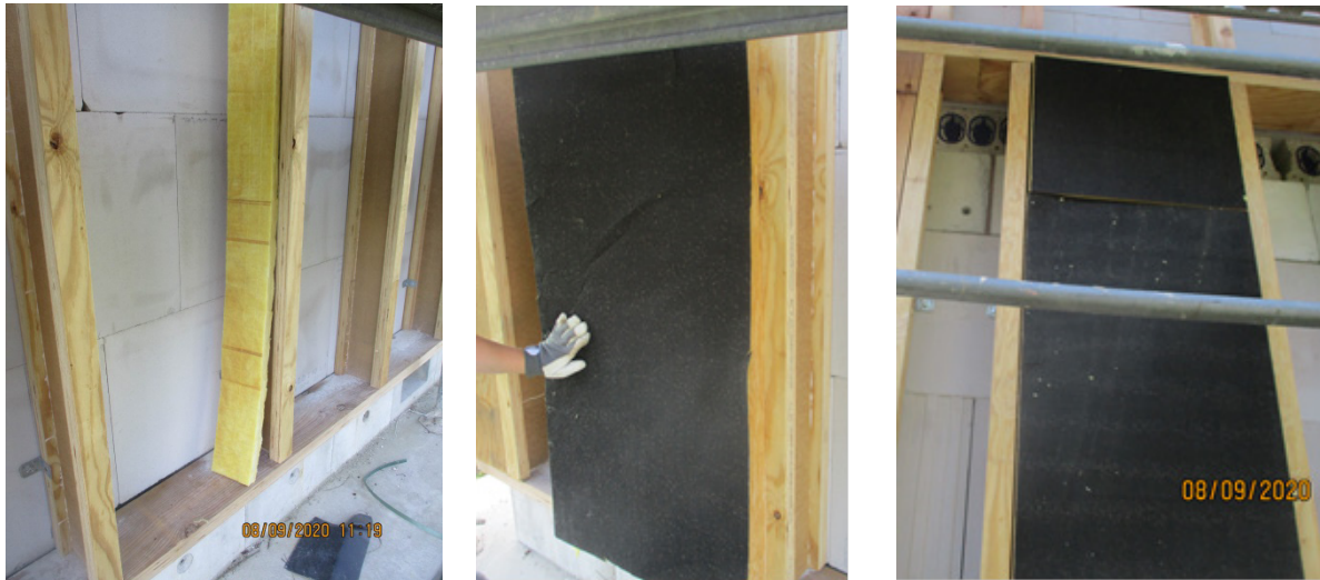
Bild 223 Verlegen der Fassadendämmung - seitliche Dämmstreifen an den Stegträgern (links) Einbau der Dämmmatte (Mitte) und vollkommen gefülltes Gefach (rechts)
