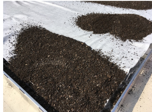
Bild 196 Vegetationssubstrat zur Begrünung des Daches
