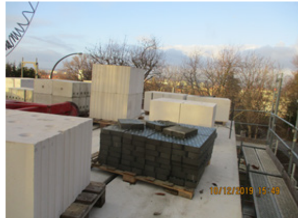
Bild 153 Verlegen der Spannbetondeckenplatten im OG mittels Autodrehkran- Befestigung der Platten zum Ringanker und unterstehenden KS-Wänden- Bereitstellung der erforderlichen Steine für Attikageschoss
