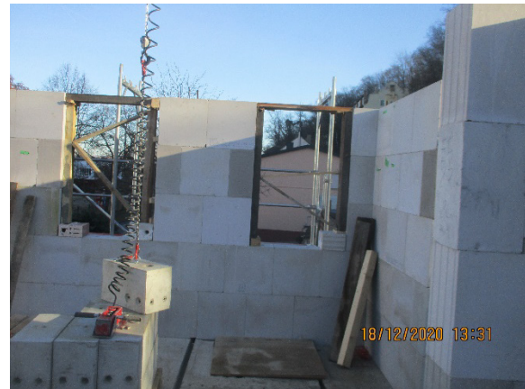
Bild 309 Fortsetzung des Vermauerns der KS-Wände im OG
