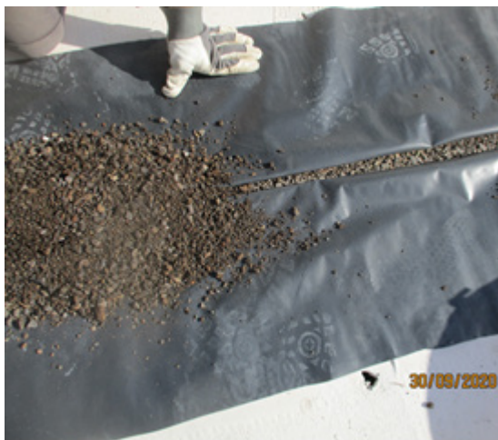
Bild 260 Rückbau des Dachaufbaus - Abtragung des Füllkieses
