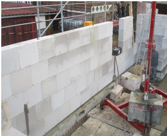
Bild 296 Fortsetzung des Vermauerns der KS-Quadro-Steine im EG
