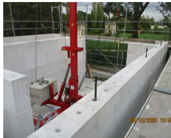
Bild 273 Rückbau des OG - Demontage des Ringankers
