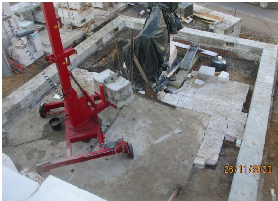
Bild 293 Fundamente der Außenwände in Trockenbauweise
