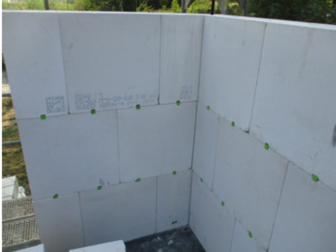
Bild 137 Rohbauwand mit Kreuzverbindern
