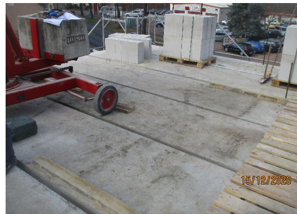
Bild 307 Verlegte Deckenplatten über EG
