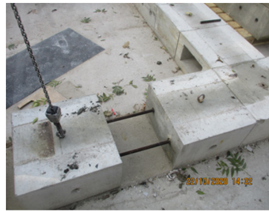
Bild 281 Rückbau der Fundamentebene - Fortsetzung der Demontage der Fundamentsteine
