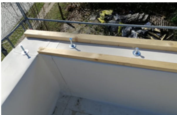
Bild 197 Holzlatten entlang der Attika mit unterschiedlicher Höhe zur Bildung der Attika-Gefälle
