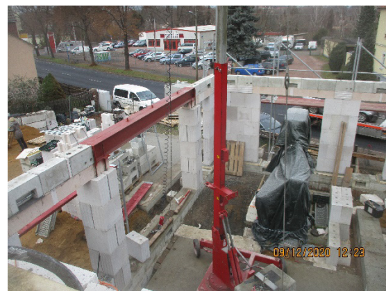
Bild 305 Montage des Ringankers im EG - Endmontage der Stahlträger in der Ringankerebene und Verbindung mit den Ringankersteinen
