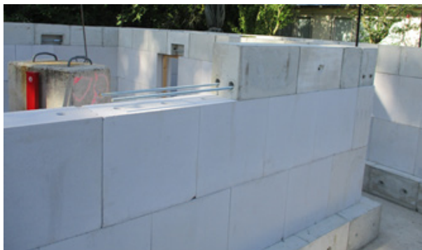
Bild 125 Montage des Ringankers für die Unterkellerung
