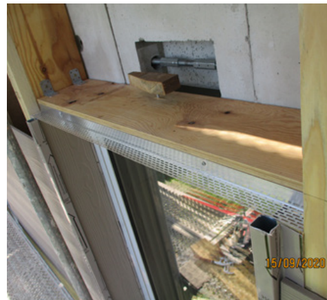
Bild 228 Montage des Fassadensystems des Fassadensystems links - Montage der Profile und Passstücke in die Fenster- und Türlaubungen rechts
