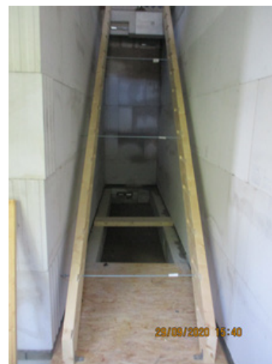
Bild 247 Rückbau der Treppe – Demontage der Holzträger und OSB-Platte
