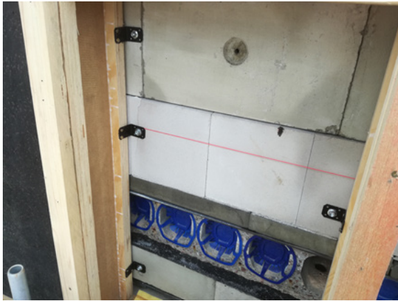
Bild 327 Fassaden-Remontage: Montage der Stegträger- Befestigung der tragenden Winkerverbinder am KS-Stein durch demontierbare Schrauben
