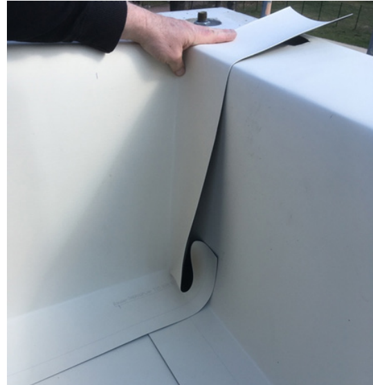
Bild 180 Ecke ausbilden mit hochstehender Eckfalte
