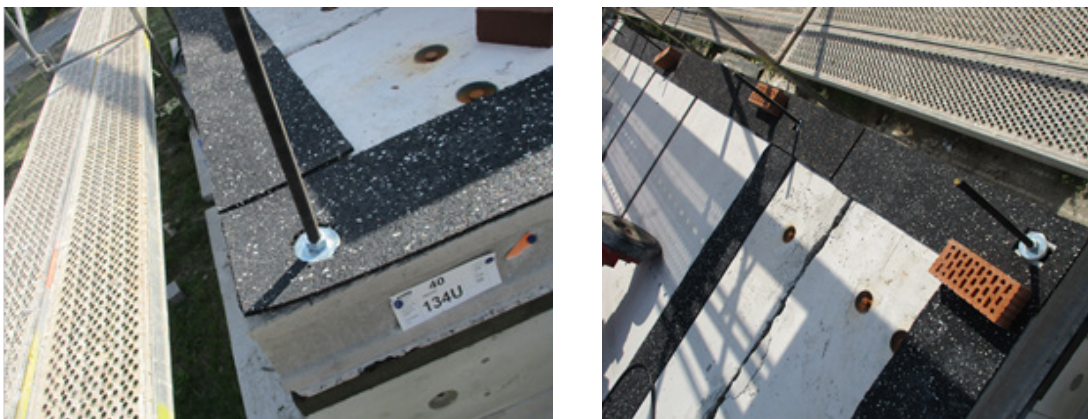
Bild 131 Ausgleichschicht aus Hartgummiplatten bzw. -streifen in verschiedenen Stärken
