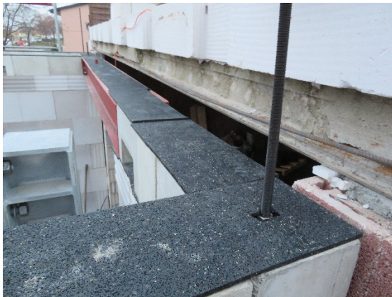
Bild 306 Montage der Deckenplatten über EG - Verlegen einer Hartgummischicht zur Lastverteilung
