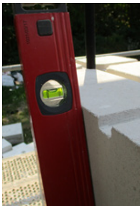
Bild 134 Anwendung von Wasserwaage und Rechtwinkel zur Vermeidung einer Schiefstellung der KS-Wände im EG
