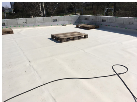
Bild 172 Fertiggestellte Dachabdichtung mit provisorischer Beschwerung
