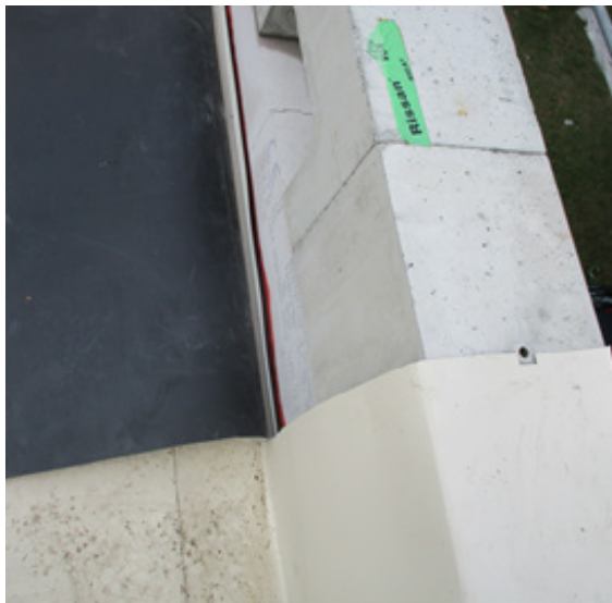
Bild 254 Rückbau des Dachaufbaus - Teilung der FPO-Abdichtungsbahnen in drei Teile
