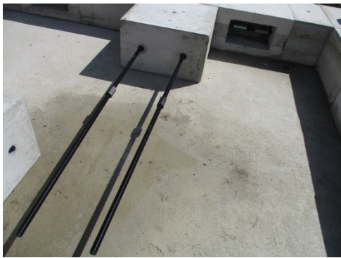
Bild 120 Eckausbildung und Anschluss Innenwandfundament
