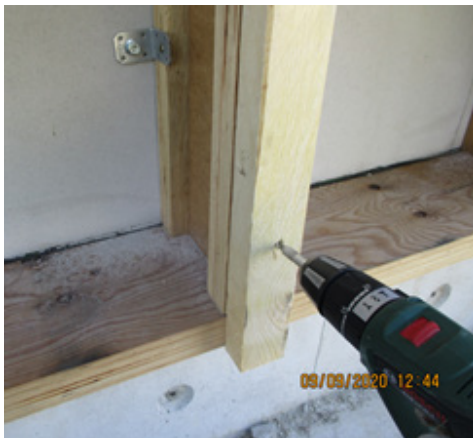
Bild 222 Montage der Holzlatten an den Stegträgern als Grundlage zur Montage der Eternitplatten links und fertiggestellte Unterkonstruktion rechts
