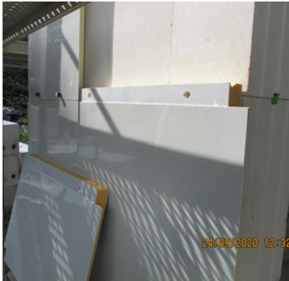
Bild 240 Demontage der Vakuumpanelle - Abschrauben der Polyamidanker
