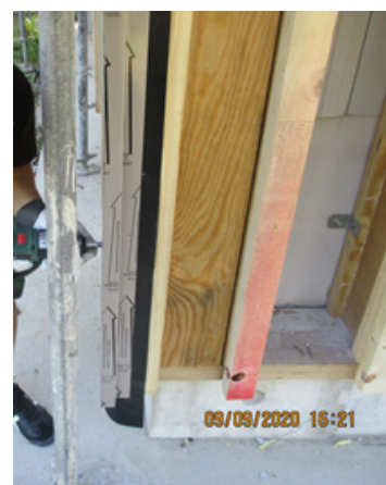
Bild 225 Montage des Fassadensystems - Montage der Eckprofile
