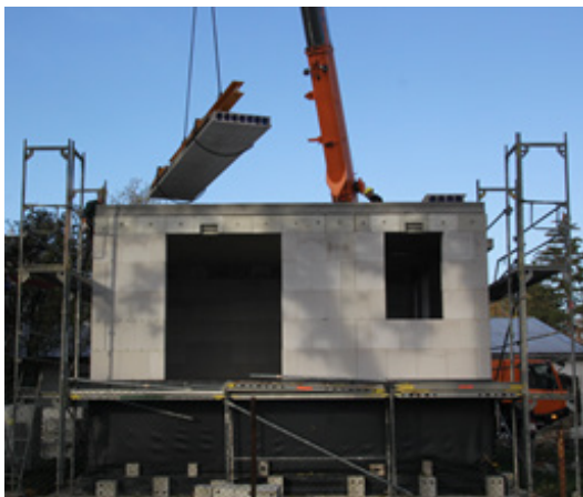
Bild 149 Anordnung der Lastplatten laut Verlegplan
