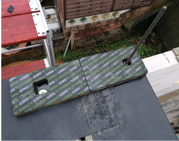
Bild 314 Thermische Trennung des Attikageschosses mittels 5 cm Schaumglasstreifen
