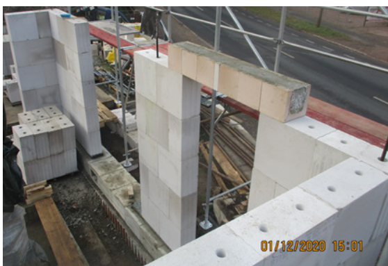
Bild 302 Erhöhung des Erdgeschosses mittels Einsatzes von KS-Halbsteinen und Stürzen
