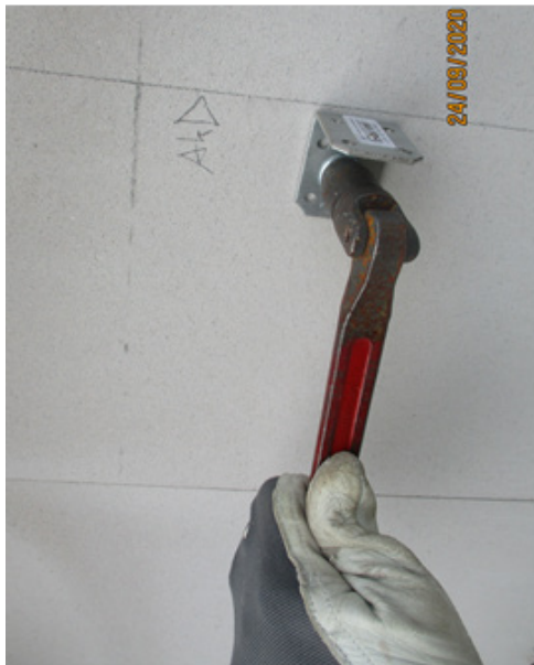
Bild 238 Abschrauben eine Befestigungswinkel für Stegträger
