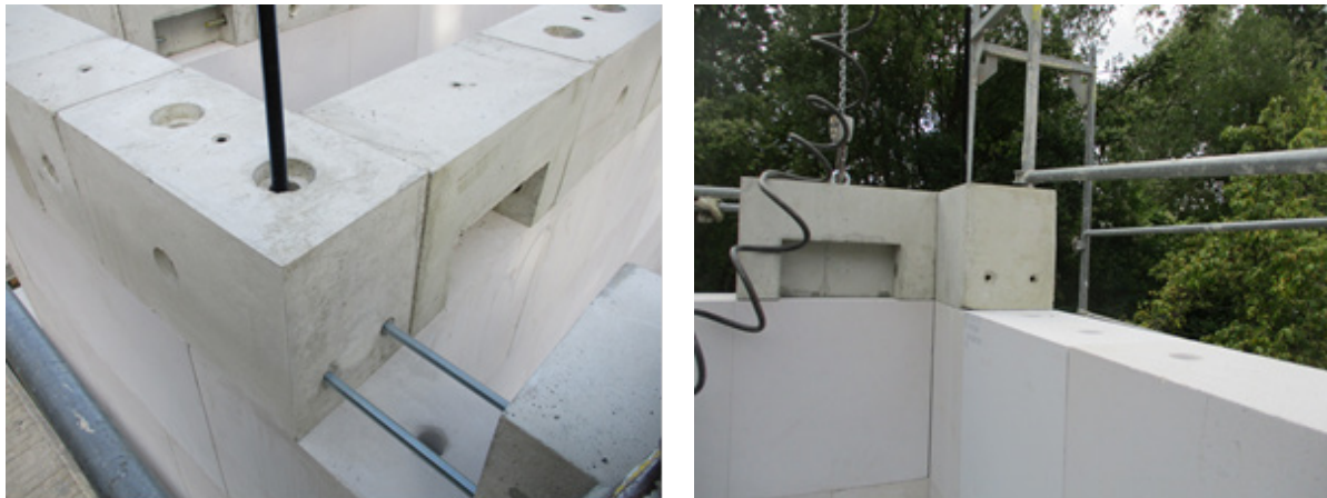
Bild 139 Fortsetzung der Montage des Ringankers im EG - Einschrauben der horizontalen Spannglieder M16 - Einfädeln der Ringankersteine durch horizontal Aussparungen
