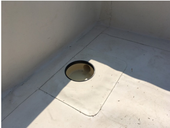
Bild 192 Überlappung der Dichtmanschette mit der Attika-Abdichtung - Endzustand
