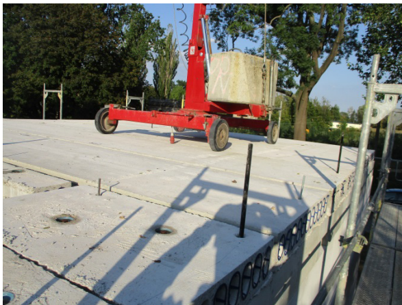
Bild 146 Fertigstellung der Deckenmontage über EG- Außen- und Innenansicht
