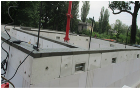
Bild 127 Thermische Entkopplung der Unterkellerung durch druckfeste Schaumglasstreifen
