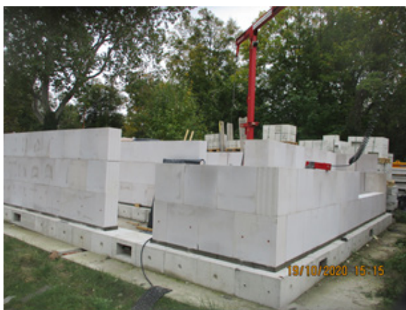
Bild 276 Rückbau des EG - Rückbau der KS-Wände
