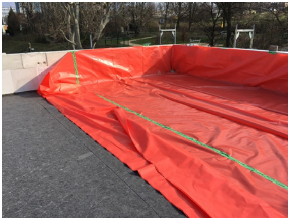
Bild 161 Verlegung der Dampfsperre auf Vliesbahn mit dampfdichter Verklebung der Stöße
