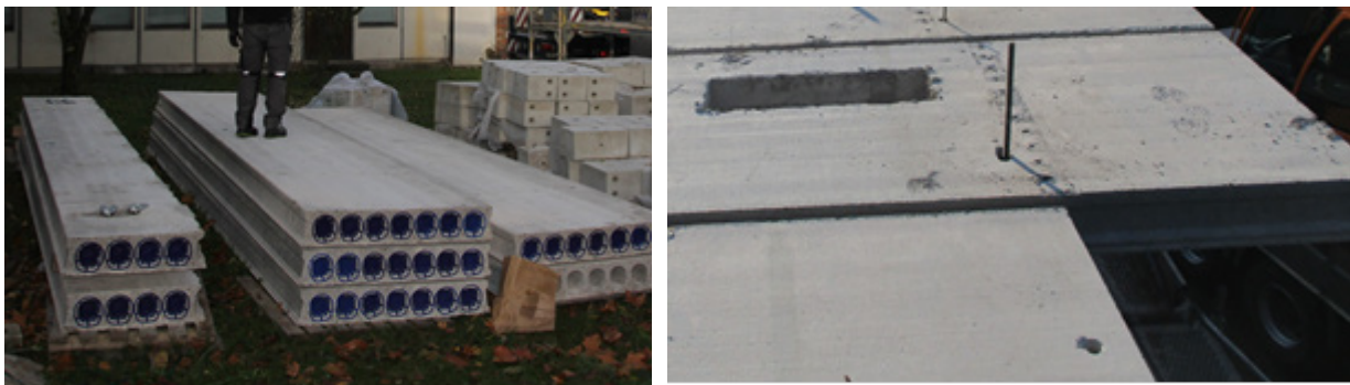
Bild 117 Hergestellte und angepasste Deckenplatten von DW-Systembau
