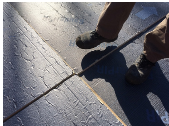
Bild 168 Fortpflanzung der Unebenheiten aus den unteren Schichten
