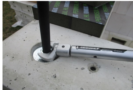
Bild 126 Verspannen des Ringankers am Spannstein durch Spannschlösser
