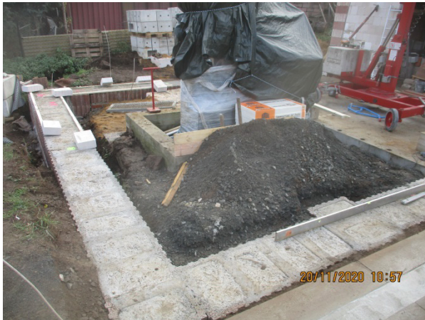
Bild 287 Vorbereitung der Streifenfundamente zur Herstellung der Aufbauebene für das Forschungsgebäude in Meißen – Schalungssteine mit Ortbeton
