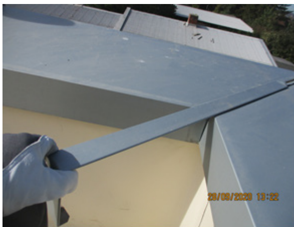
Bild 248 Rückbau des Attikaaufbaus – Demontage der Bleche und Sondereckprofile
