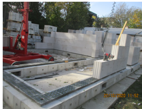
Bild 277 Rückbau des EG - Freilegung der Schaumglasschicht
