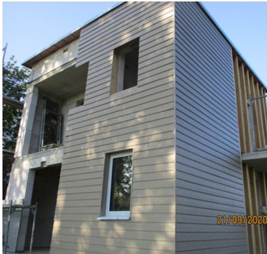
Bild 229 Fertigstellung des exemplarischen Fassadensystems aus Eternitplatten von CEDRAL
