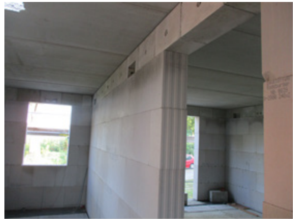
Bild 146 Fertigstellung der Deckenmontage über EG- Außen- und Innenansicht
