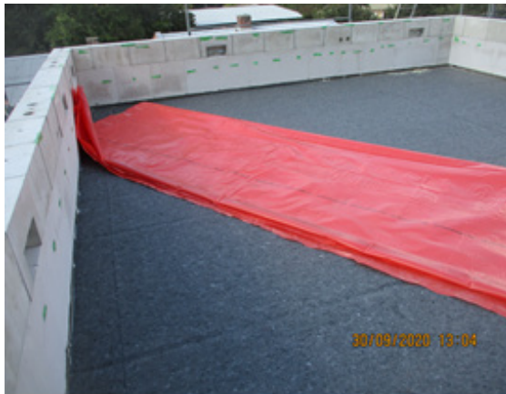
Bild 258 Rückbau des Dachaufbaus - Rückbau der Dampfsperre
