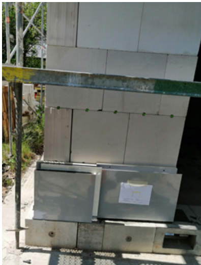
Bild 213 Verlegen der entwickelten Vakuumpaneele von Variotec an den vorgesehenen Kreuzverbindern
