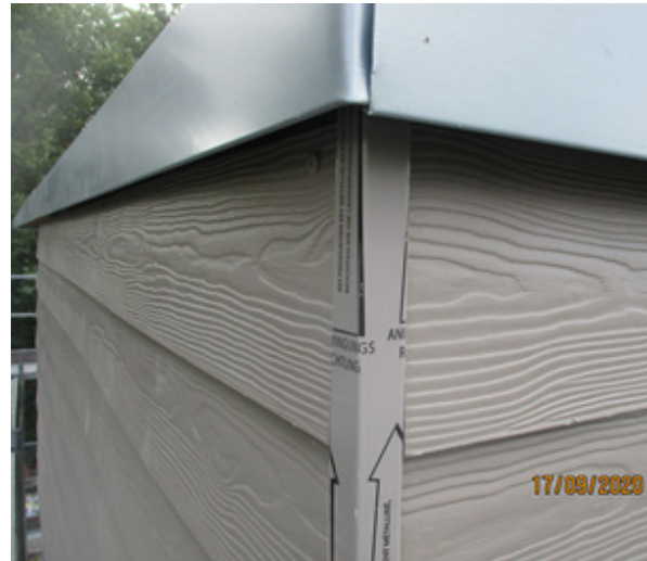
Bild 229 Fertigstellung des exemplarischen Fassadensystems aus Eternitplatten von CEDRAL
