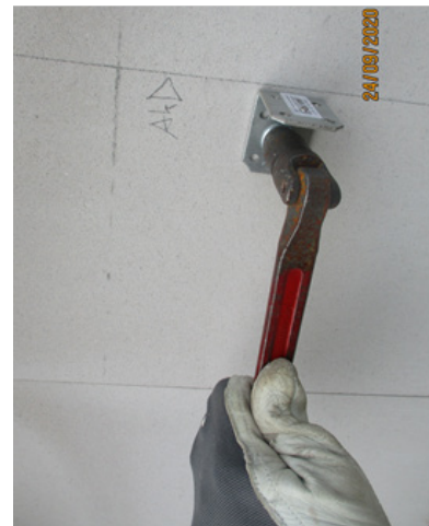
Bild 237 Demontage der Befestigungswinkel für die Stegträger und die Bohlen
