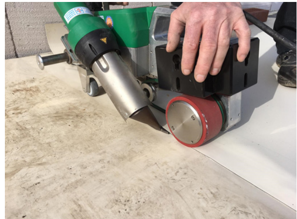
Bild 322 Verschweißen der verlegten Abdichtungsbahnen mit dem speziellen Schweißautomat
