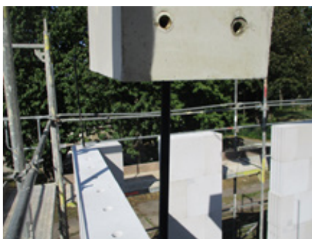
Bild 138 Beginn der Montage des Ringankers im EG mit einem Eckstein - Einfädeln der Spannglieder M20 - Versetzen der Ringankersteine mittels Mauerkrans durch Anwendung der Hülsenschrauben
