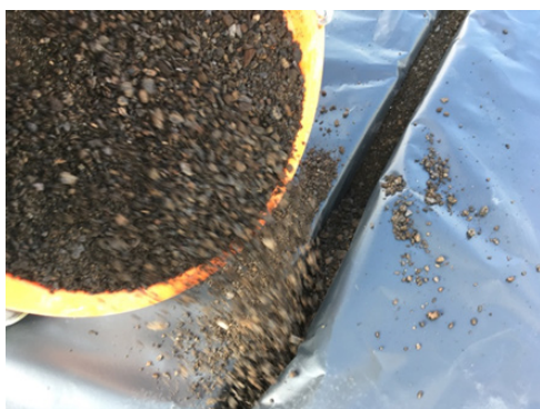
Bild 157 Verfüllen der Deckenelementfugen mit feinem Kies (bis 8mm)
