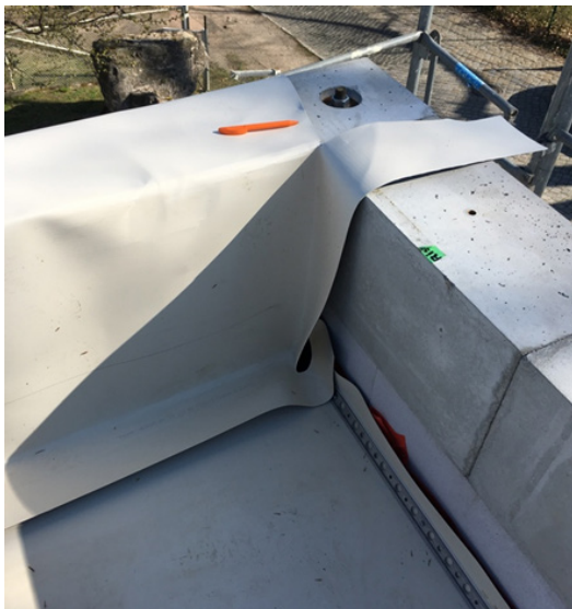
Bild 179 Dichtbahn bis in die Kehle schieben mit einer 15 cm Überlappung
