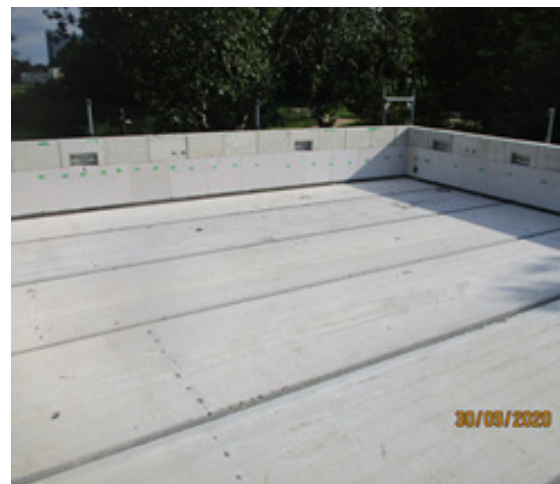
Bild 261 Endzustand Rückbau des Dachaufbaus - 100% Demontierbarkeit
