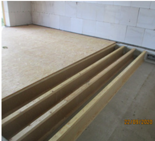
Bild 244 Rückbau des Fußbodenaufbaus - Demontage der Stegträger
