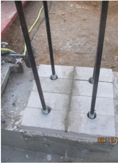
Bild 300 Aufmauern einer thermischen Trennschicht unter den KS-Pfeilern aus Kimmsteinen
