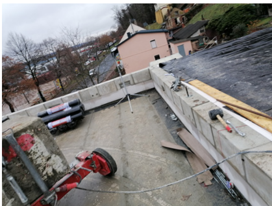
Bild 316 Errichtung des Attikageschosses - Ringankerebene
