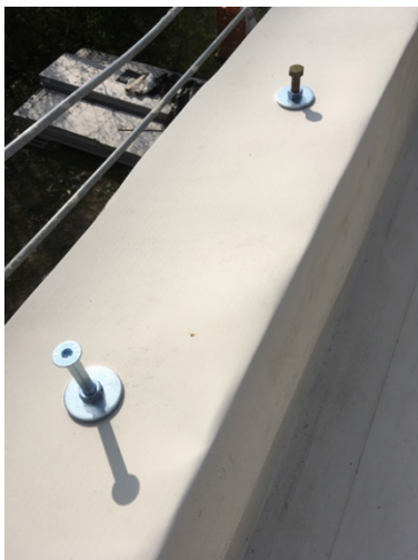
Bild 183 Zwischenfixierung der Abdichtung auf der Attika mittels Gewindebolzen und Unterlegscheiben in den Gewindehülsen der Steine
