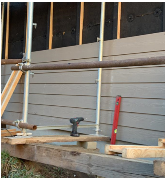
Bild 333 Fortsetzung des Fassadenausbaus
