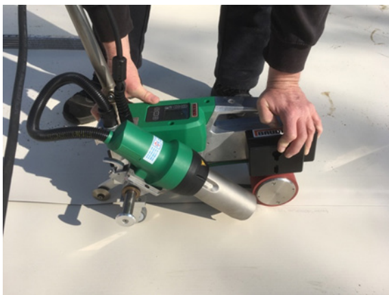
Bild 171 Verschweißen der Bahnen mit Schweißautomat
