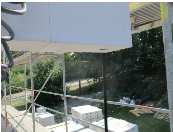
Bild 132 Einfädeln der Spannstäbe in die Kanäle der KS-Steine
