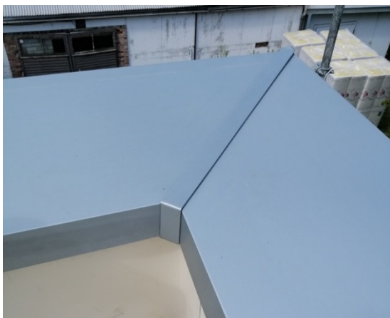
Bild 205 Obere Zinkbleche - Fertigstellung der Eckabbildung
