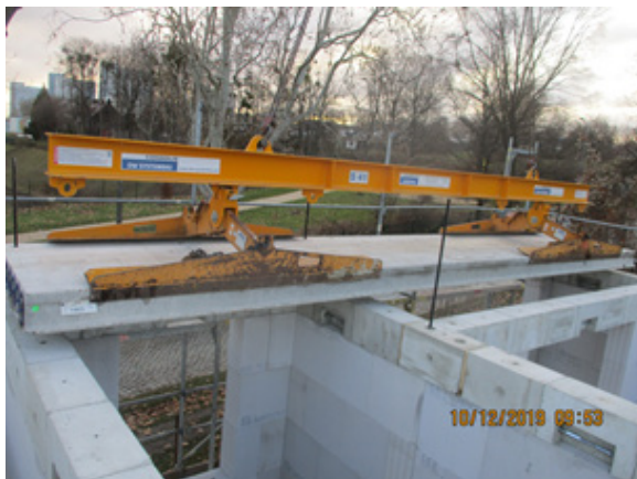
Bild 153 Verlegen der Spannbetondeckenplatten im OG mittels Autodrehkran- Befestigung der Platten zum Ringanker und unterstehenden KS-Wänden- Bereitstellung der erforderlichen Steine für Attikageschoss
