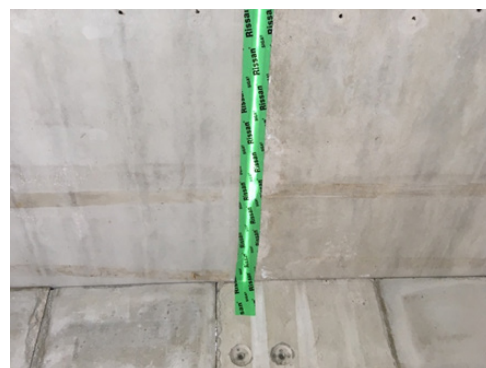
Bild 158 Verkleben der Spalten zwischen den Deckenelementen
