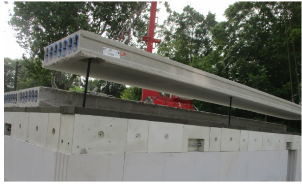
Bild 128 Montage der Deckenplatten für die Unterkellerung
