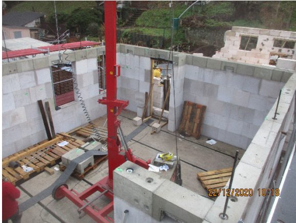
Bild 312 Fertigmontage des Ringankers im OG – Verspannen zu den stehenden KS-Wänden
