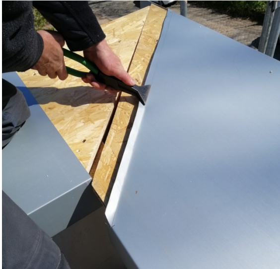
Bild 203 Verlegen der oberen Zinkbleche - Eckabbildung
