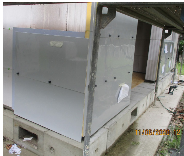
Bild 217 Montierte Vakuumpaneele im Bereich der Kreuzverbinder-Eckverbindung
