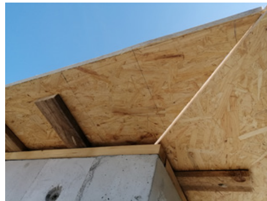
Bild 200 OSB-Holzplatten - Ansicht von Unten - Eckabbildung - Der Überstand deckt später die Dämmfassade ab
