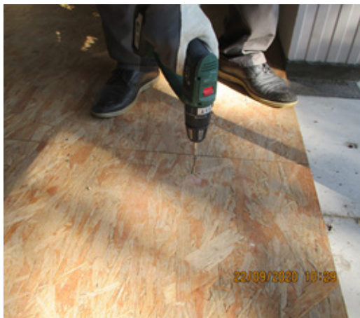
Bild 242 Rückbau des Fußbodenaufbaus - Demontage der OSB-Platten
