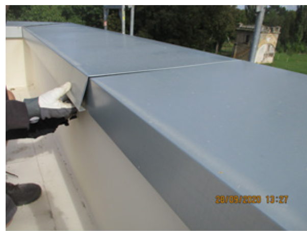
Bild 249 Rückbau des Attikaaufbaus – Demontage der Bleche als Einklicksystem
