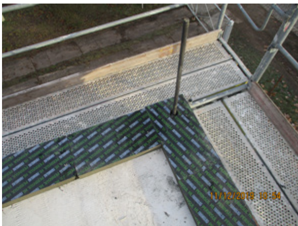
Bild 154 Thermische Trennung durch Schaumglasstreifen
