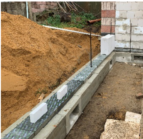
Bild 294 Vermauern der KS-Quadro-Steine im EG - Thermische Trennung mit Schaumglasstreifen
