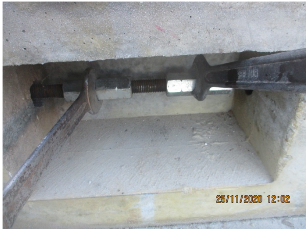
Bild 291 Verspannungsprozess - Montage der Fundamentebene
