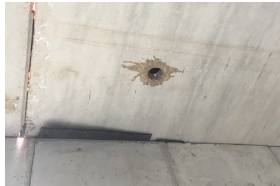
Bild 160 Deckendurchbruch für Entlüftung Sanitärinstallation
