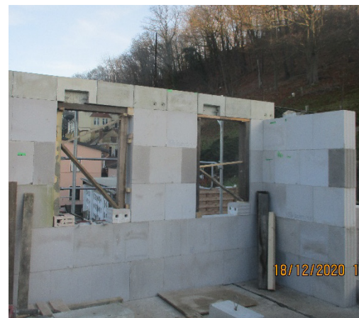
Bild 311 Montage des Ringankers im OG - Anwendung von Stützsystemen im Bereich der Öffnungen
