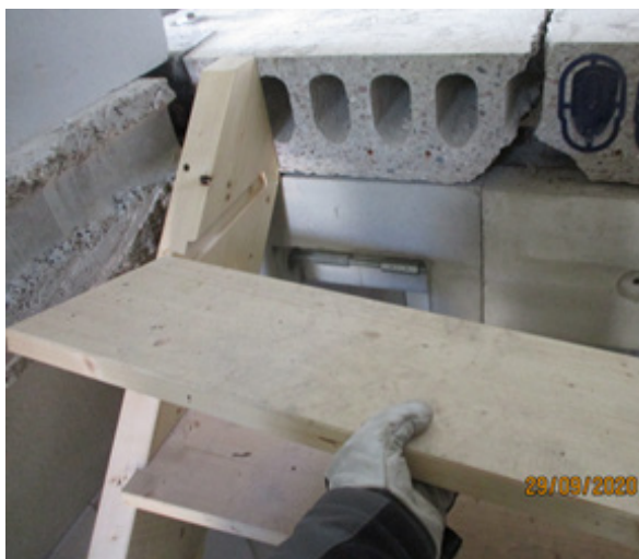
Bild 246 Rückbau der Treppe – Demontage der Stufen und der Gewindestangen
