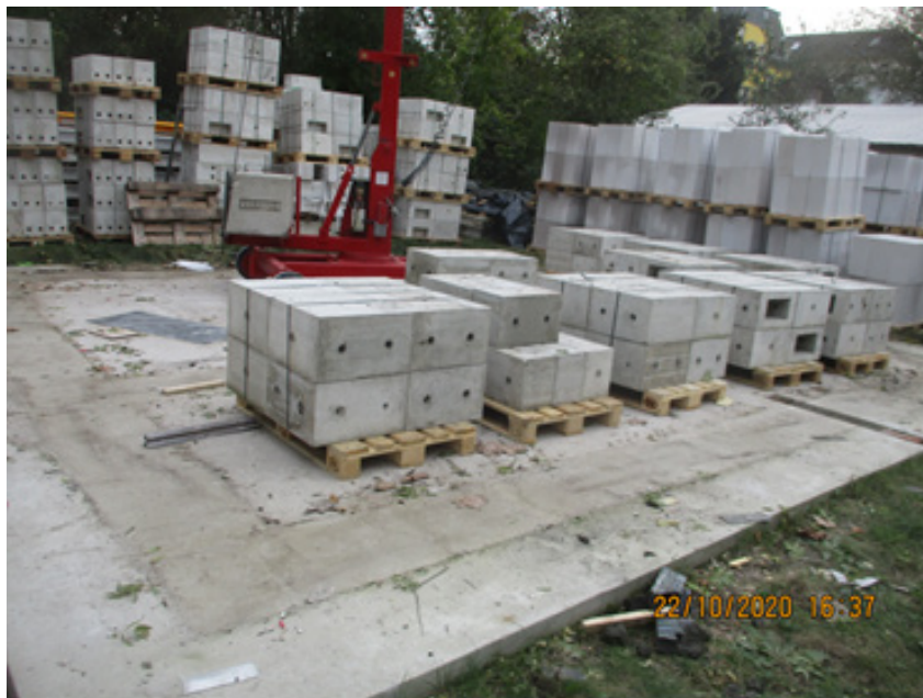
Bild 282 Ende der Demontage des Rohbaus des Versuchshauses - 100% Demontierbarkeit
