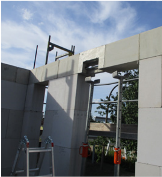
Bild 141 Wegnahme der Montageunterstützung nach dem Vorspannen des Ringankers
