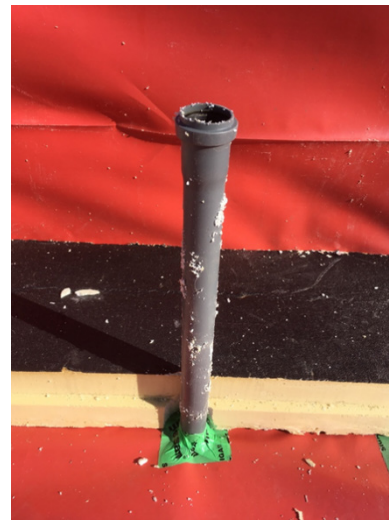
Bild 185 Einbettung Grunddämmung
