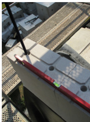
Bild 134 Anwendung von Wasserwaage und Rechtwinkel zur Vermeidung einer Schiefstellung der KS-Wände im EG
