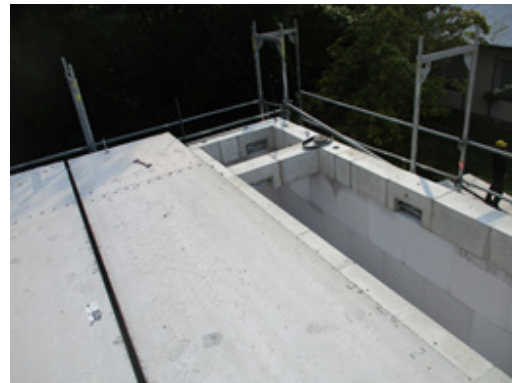
Bild 145 Einfädeln der vertikalen Spannglieder M20 durch die Aussparungen – Verspannung der Deckenplatten zum Ringanker durch die vertikalen Spannglieder M20-
