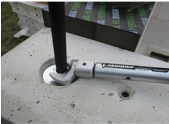
Bild 142 Fortsetzung der Montage des Ringankers im EG in alle Richtungen laut des Positionsplans – Vervollständigen der Montage
