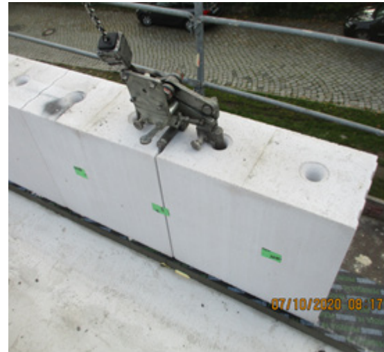
Bild 265 Rückbau des Attikageschosses - Rückbau der KS-Steine
