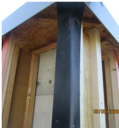
Bild 224 Montage des Fassadensystems - Anbringen der Dichtungsbahnen an den Holzlatten
