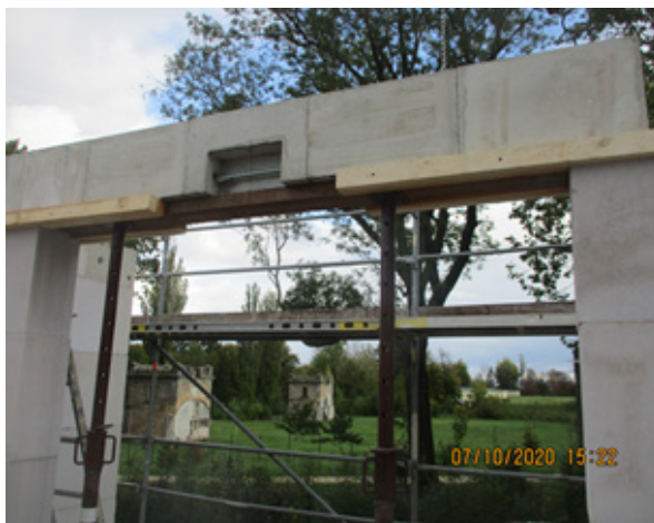
Bild 272 Rückbau des OG - Montagestützen sichern die Lage der Ringankersteine über Öffnungen
