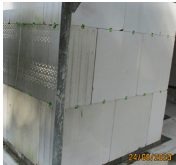
Bild 241 Enddemontage der VIP-Paneele von den Kreuzverbindern
