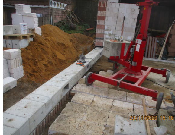
Bild 292 Bildung der Fundamentstreifen – Montage der Fundamentebene
