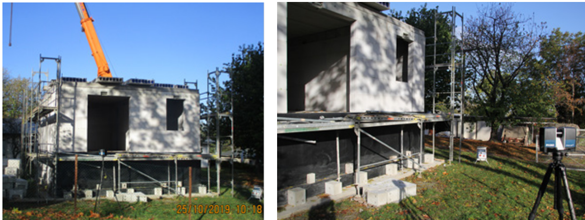
Bild 150 3D-Verformungsmessung mittels Laser-Scanning vor und nach der Durchführung des Belastungstests.
