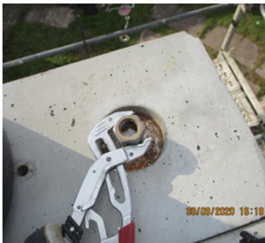
Bild 262 Rückbau des Attikageschosses - Rückbau des Ringankers-Ablösung der Vertikalspannglieder
