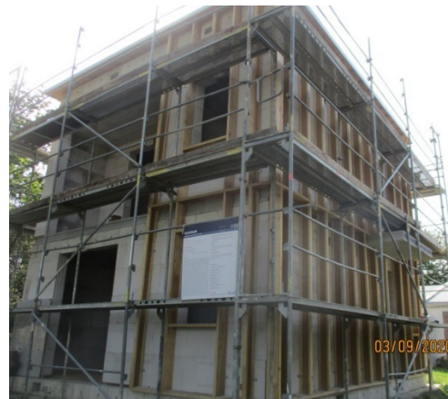
Bild 222 Montage der Holzlatten an den Stegträgern als Grundlage zur Montage der Eternitplatten links und fertiggestellte Unterkonstruktion rechts
