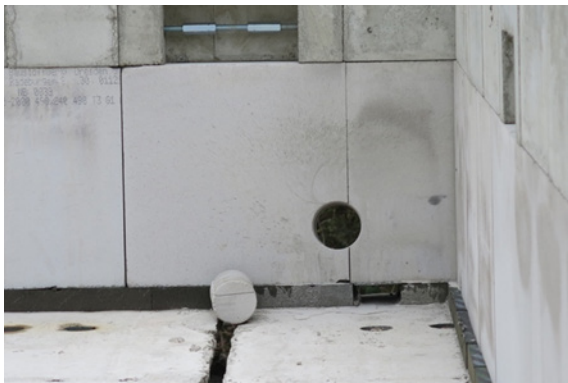
Bild 159 Wanddurchbruch Attika für Dachentwässerungsanlage
