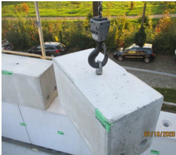
Bild 264 Rückbau des Attikageschosses - Rückbau der Ringankersteine-
