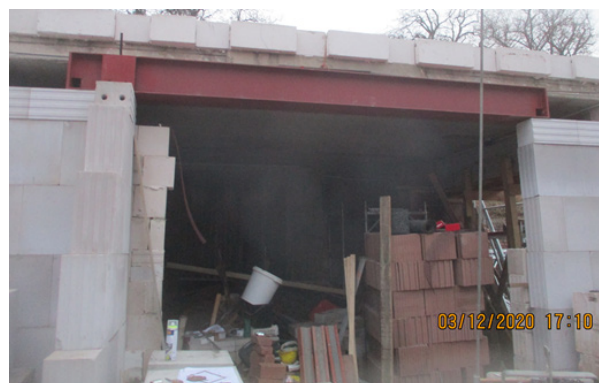
Bild 303 Errichtung des EG nach dem Prinzip des Verbundbaus - Montage der Stahlträger in der Ringankerebene
