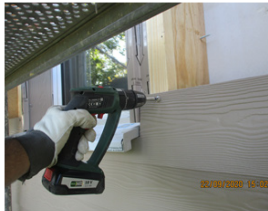
Bild 233 Demontage der Sonderpaneele an den Laibungen
