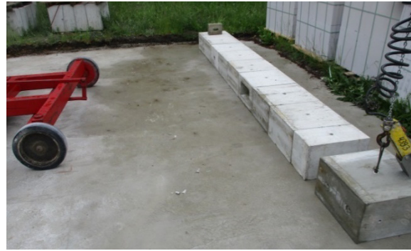
Bild 119 Verlegen der Fundamentsteine
