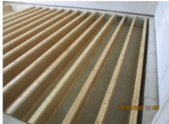
Bild 208 Verlegen der Profilträger im großen Raum - Fußbodenaufbau
