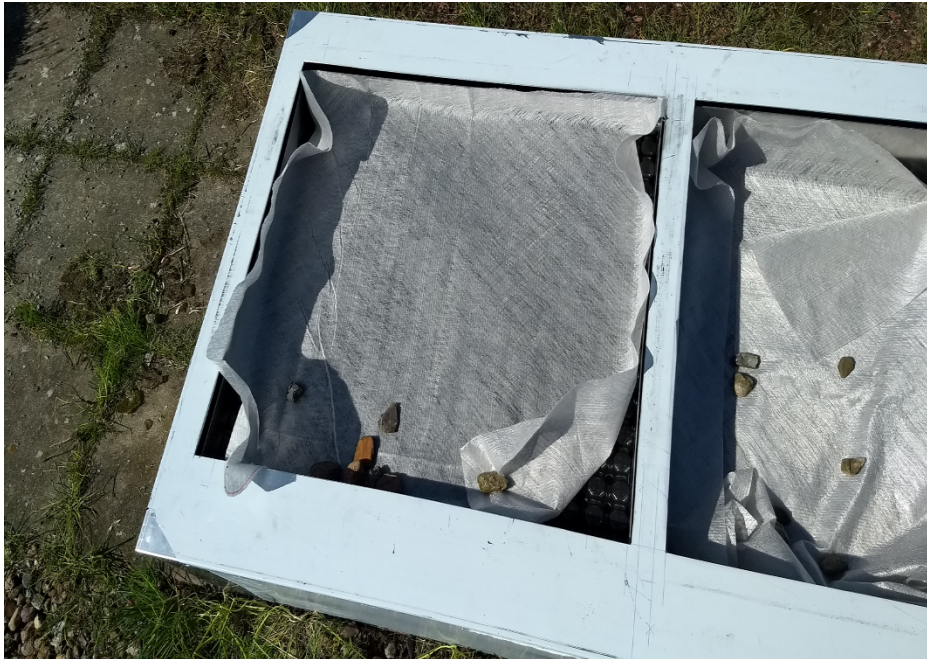
Abb. 12: Einbau des Filtervlieses.
