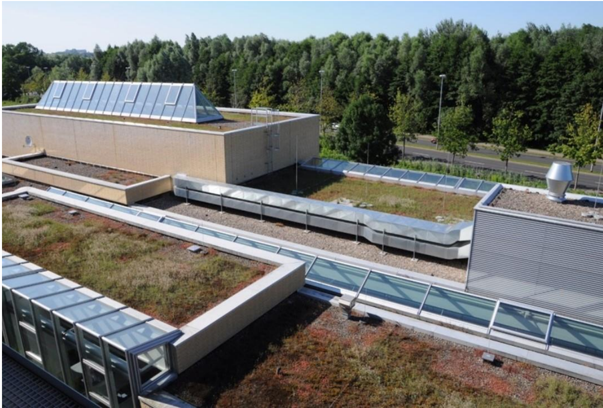
Abb. 1: Blick über die extensiven Gründächer der Hochschule Neubrandenburg (Haus 2).
