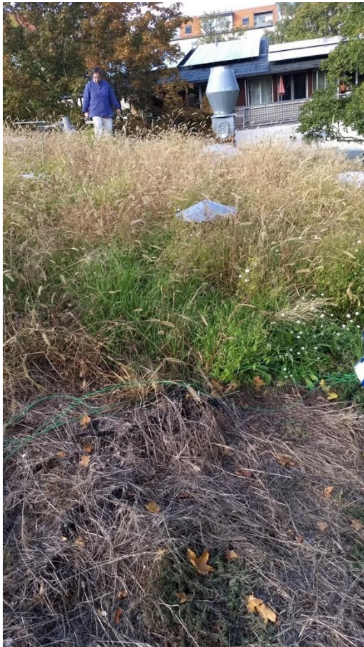
Abb. 37: Aufnahme vom 25.09.2018, im Hintergrund die bewässerte Dachfläche (36 m 2 ), im Vordergrund die unbewässerte Dachfläche auf dem Gelände der ufaFabrik (Café) in Berlin.
