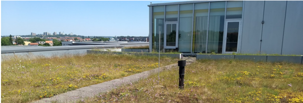
Abb. 2: Versuchsdachfläche der HSNB (Haus 3).
