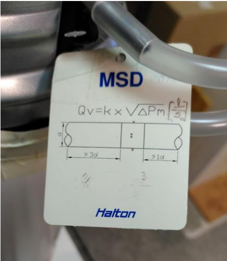
Abbildung 72: Berechnungsformel für den Volumenstrom am Druckmesskreuz [PHI]
