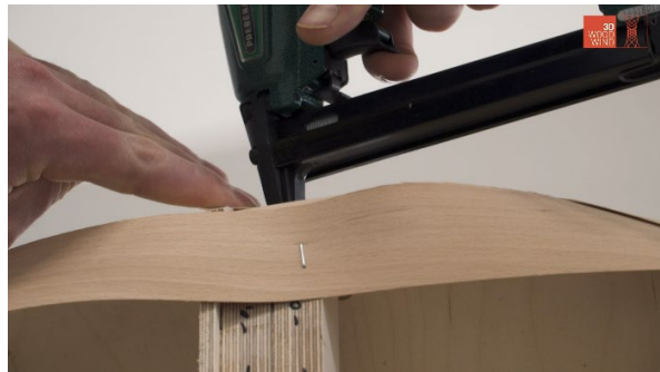
Abb. 102 Befestigung des Furniers mittels Tacker
